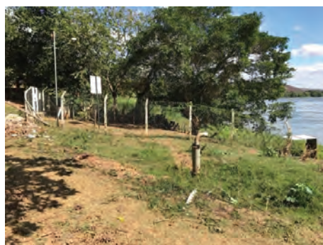
Figura 50 - Poço tubular profundo perfurado ao lado de captação de água do rio Doce em Tumiritinga, MG.
