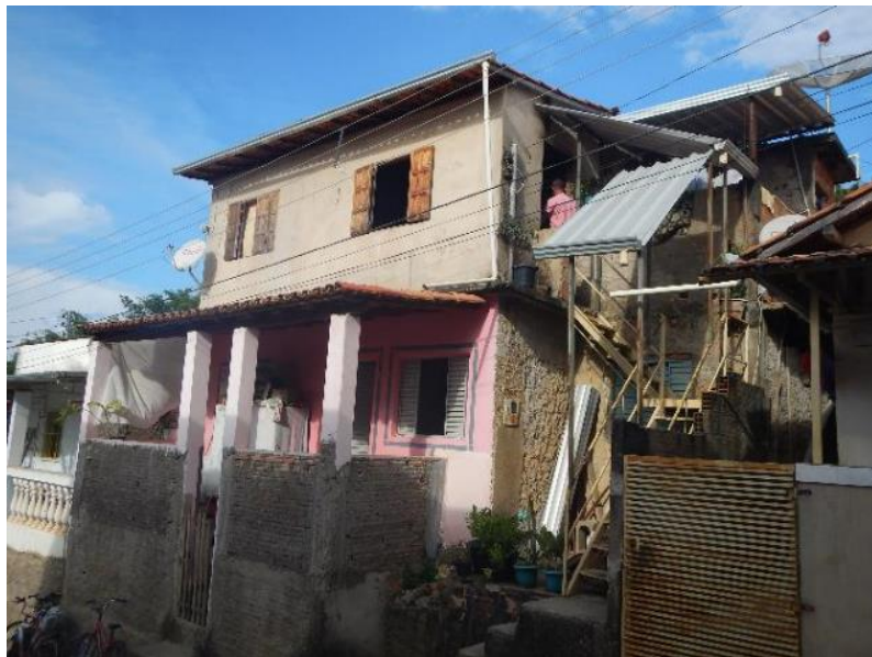
Figura 4 – Moradia temporária com problema de habitabilidade (Barra Longa). Data da imagem: 17/05/2018.
