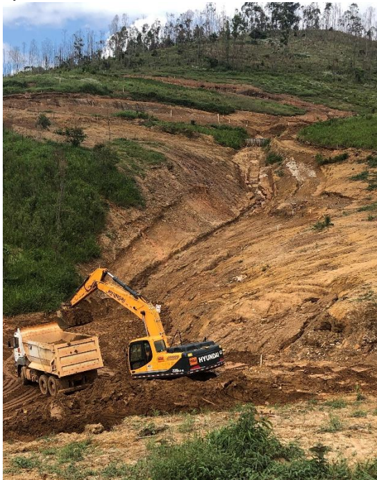
Figuras 03 e 04: Área onde está sendo executado o dreno de talvegue. Data das imagens: 24/04/2019.
