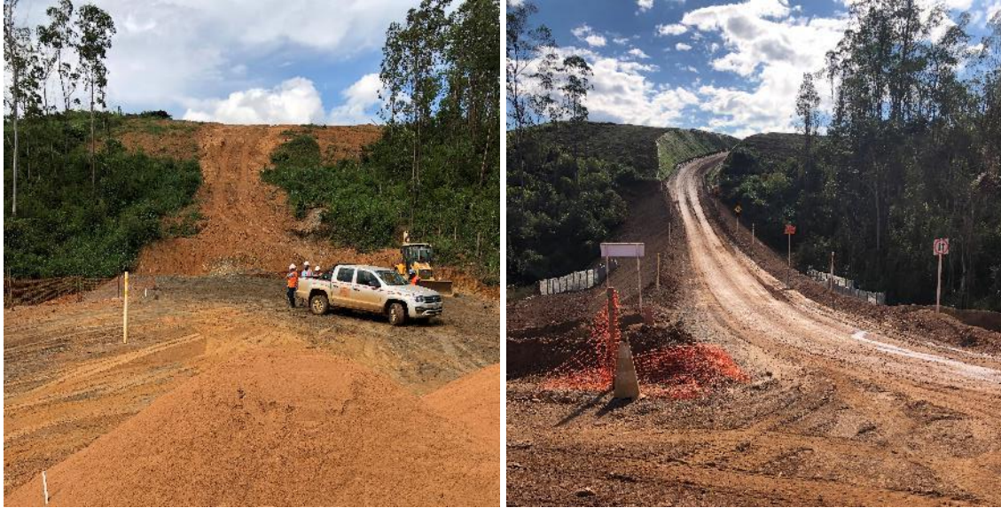
Figuras 9 e 10 - Intervenção na APP (afluente do córrego da Lavoura) para construção do desvio provisório. Data das imagens: 05/02/2019 (esquerda - terraplanagem e aterro em andamento) e 26/06/2019 (direita - acesso quase concluído).
