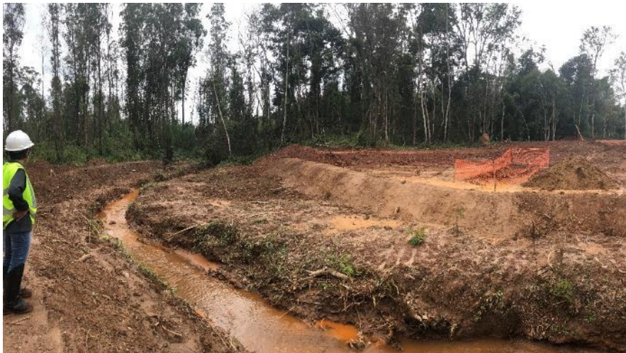
Figuras 9 e 10 - Intervenção na APP (afluente do córrego da Lavoura) para construção do desvio provisório. Data das imagens: 05/02/2019 (esquerda - terraplanagem e aterro em andamento) e 26/06/2019 (direita - acesso quase concluído).
