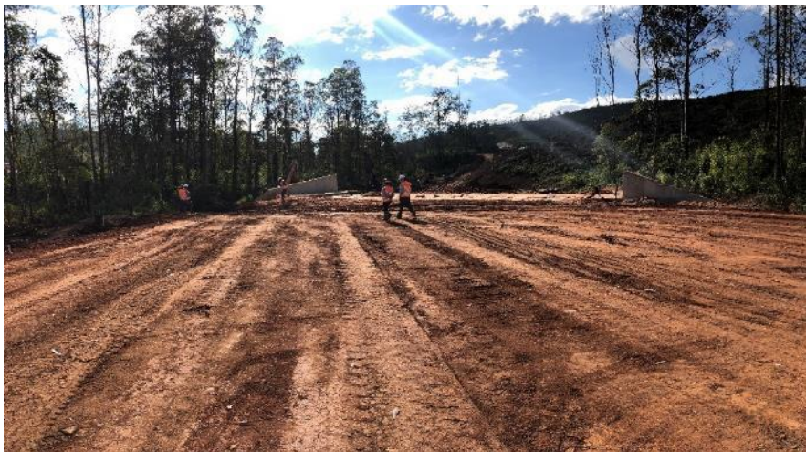
Figuras 11 e 12 - Intervenção na APP do córrego da Lavoura para construção de travessia. Data das imagens: 17/10/2018 (acima - início da terraplanagem da área) e 28/06/2019 (abaixo - aterro quase concluído).
