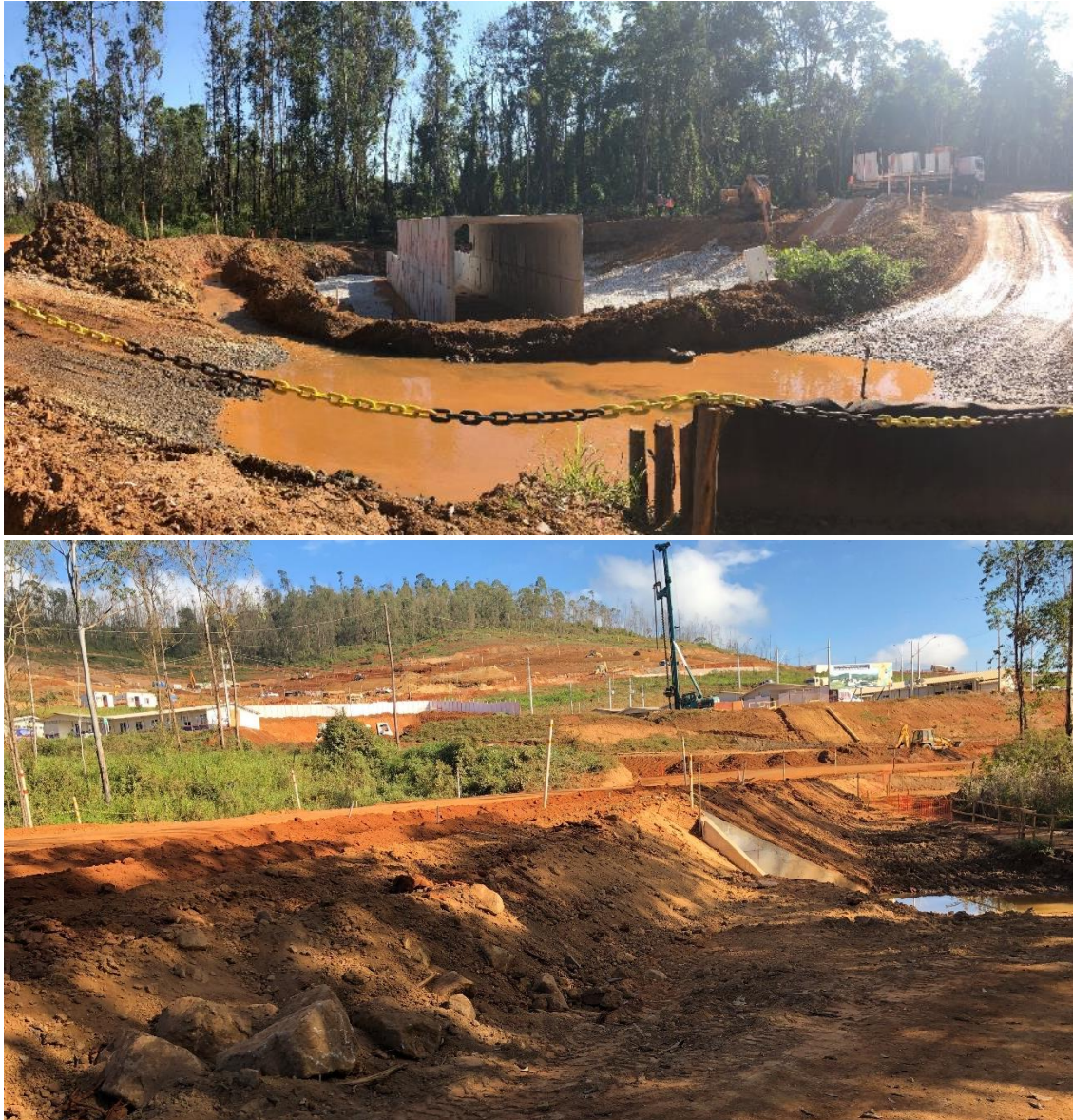
Figuras 13 e 14 - Intervenção na APP do córrego da Lavoura para construção de travessia. Data das imagens: 16/01/2019 (acima – instalação das aduelas) e 26/06/2019 (abaixo – aterro finalizado).
