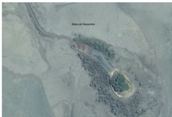
Ilhote do Passarinho: cercamento parcial (muro de concreto). Georreferenciamento e imagem: FERNANDES, M. HEIMMER, M., 2016.
