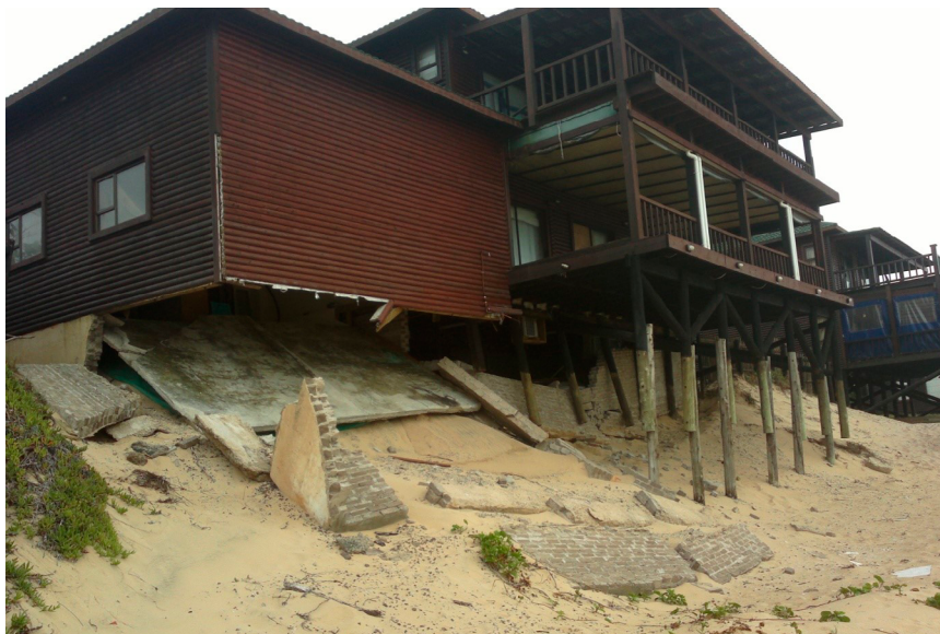
Construção por cima das dunas na Ponta D'Ouro
