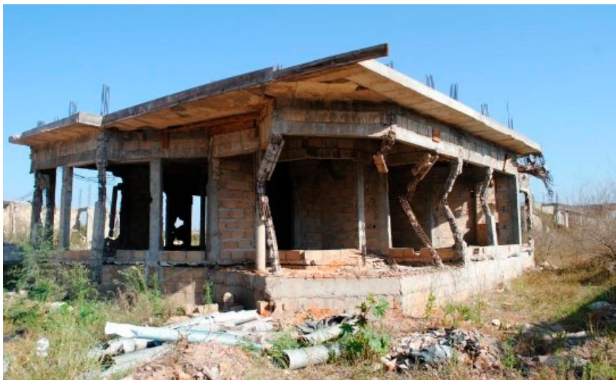
Uma das residências demolidas pelo Conselho Municipal da Cidade de Maputo
