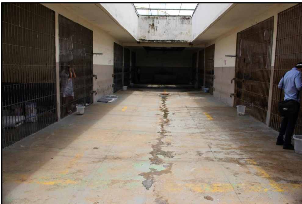
Imagem 17: Fotografia do pátio interno à carceragem. Fonte: Acervo DPE-GO, 2020.
