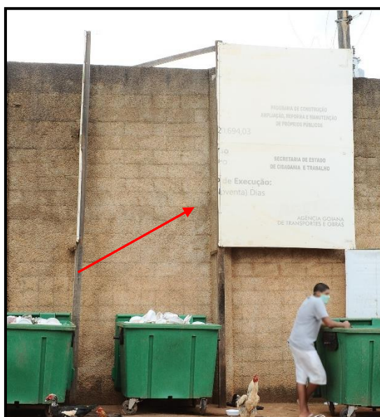
Imagem 2: Fotografia de parte da placa onde deveriam constar informações sobre a obra em execução no CASE Luziânia. Fonte: Acervo DPE-GO, 2020.
