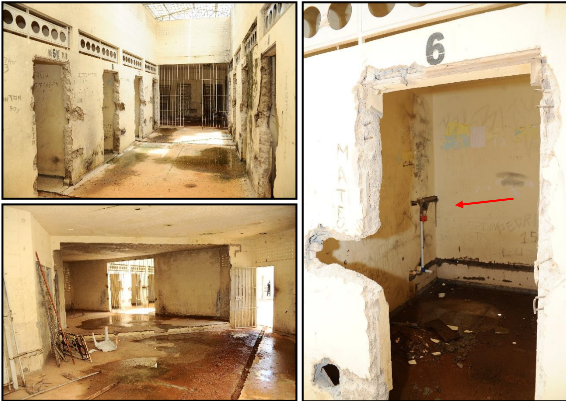
Imagem 3: Fotografias da obra em um dos módulos interditados com início das instalações hidrossanitárias nos dormitórios do CASE Luziânia. Fonte: Acervo DPE-GO, 2020.
