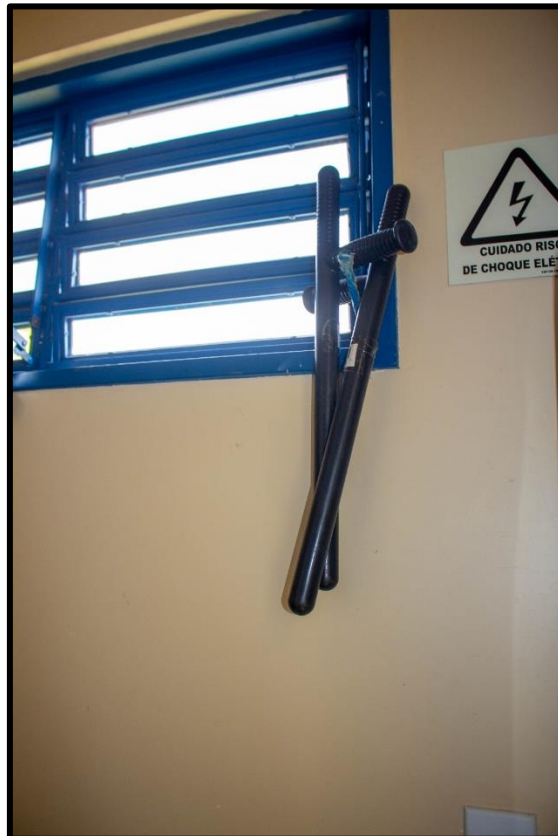
Foto 51: Tonfas em janela de sala de ATRS's no módulo – UISM. Fonte MNPCT.
