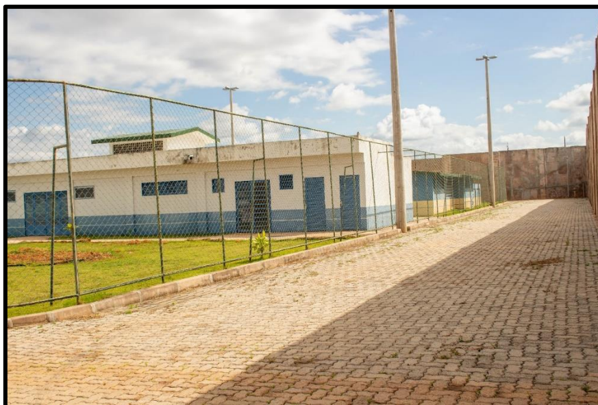
Foto 23: Visão de parte da área interna da UIFG. Fonte: MNPCT.
