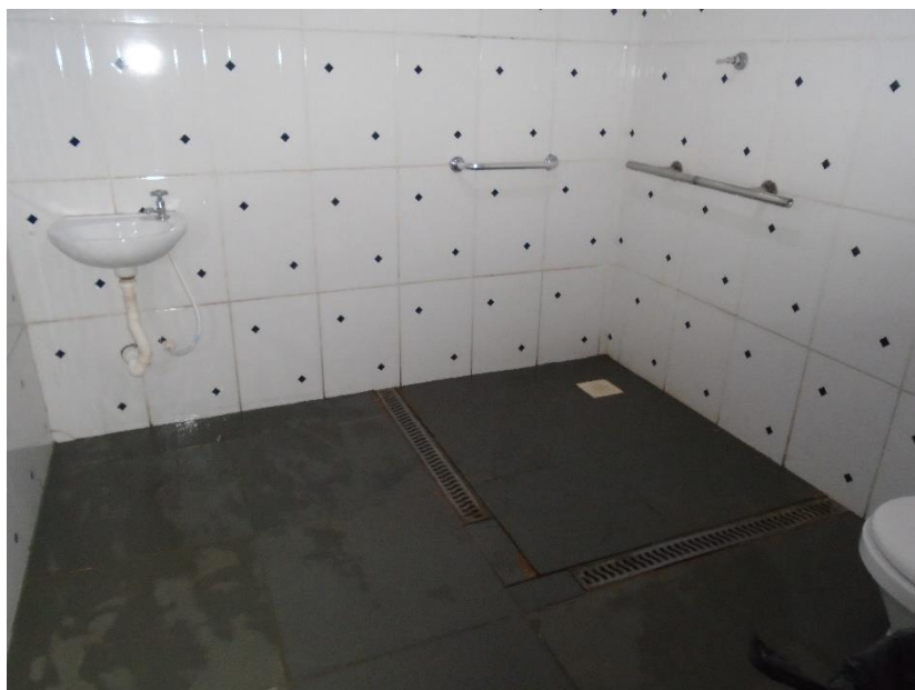
Foto 7 – Banheiro com barras de apoio em alguns pontos.
