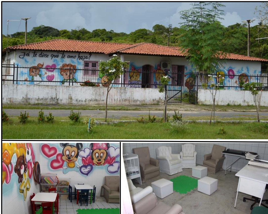
Figura 14: Fotografias com estrutura física da creche, brinquedoteca e sala de amamentação. Fonte: MNPCT, 2019.
