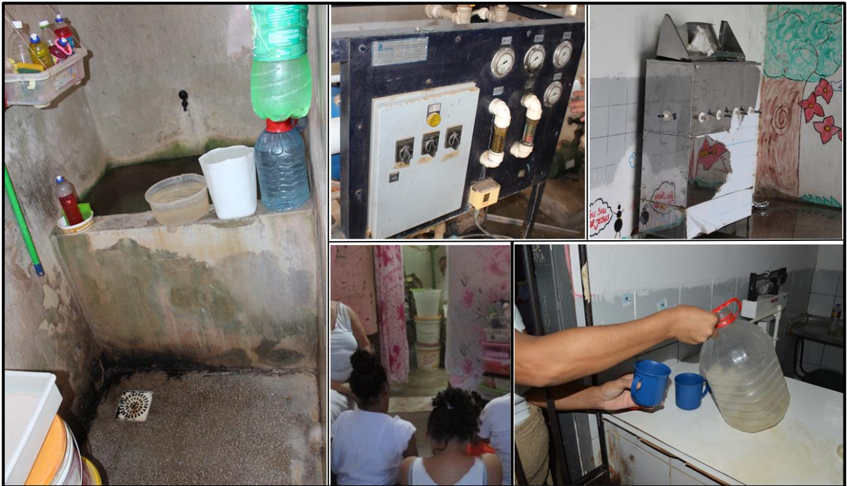
Figura 13: Fotografias da estrutura hídrica do IPF encontrado durante a inspeção. Fonte: MNPCT, 2019.
