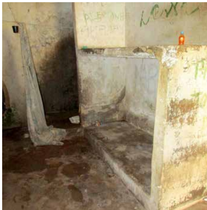
Cela de isolamento de unidade do Complexo Penitenciário de Pedrinhas, no Maranhão.
