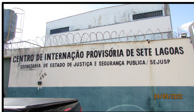
Figura 196 – Entrada da unidade
