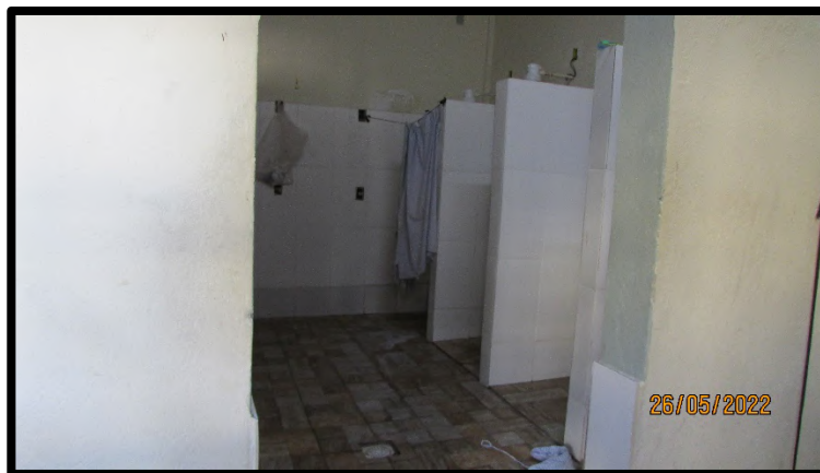
Figura 152 – Banheiro do Anexo IV
