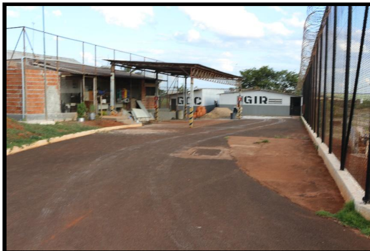
Figura 54 – Intendência do GIR em estrutura improvisada
