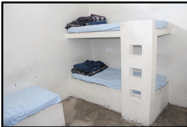
Figura 199 – Estrutura interna do alojamento 2
