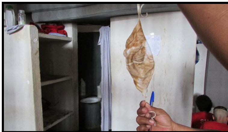
Figura 47 – Filtro de tecido colocado sobre o cano de água
