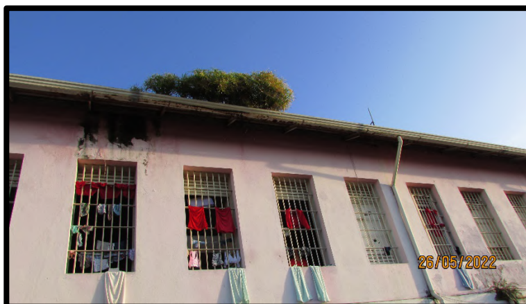
Figura 147 – Janelas das celas do Anexo I
