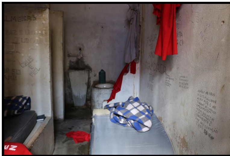
Figura 43 – Estrutura interna das celas da Ala LGBTQIA+
