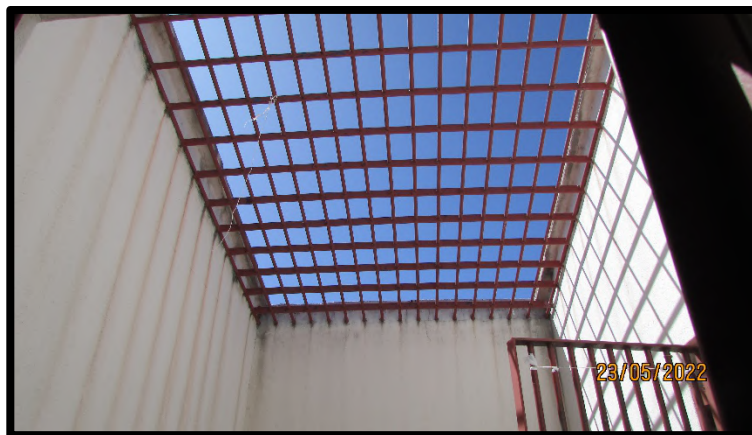
Figura 97 – Teto gradeado do pátio de banho de sol do RDD
