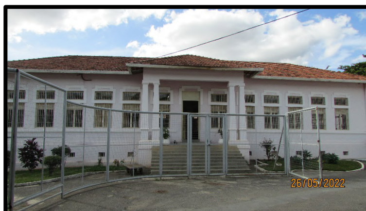
Figura 143 – Entrada da estrutura principal da unidade
