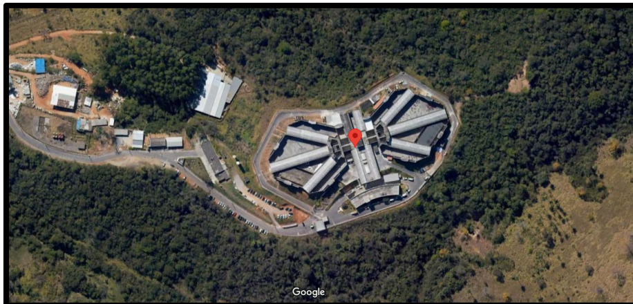
Figura 119 – Imagem próxima do Presídio Inspetor José Martinho Drumond
