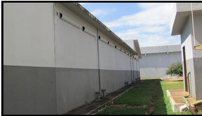
Figura 42 – Ventanas das celas tampadas por fora
