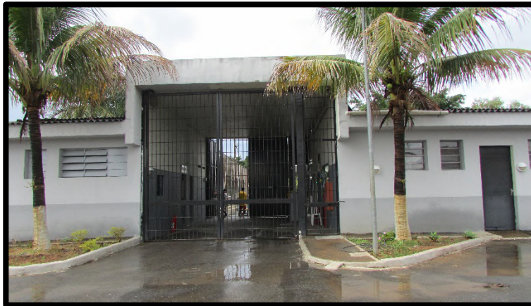
Figura 59 – Entrada da unidade
