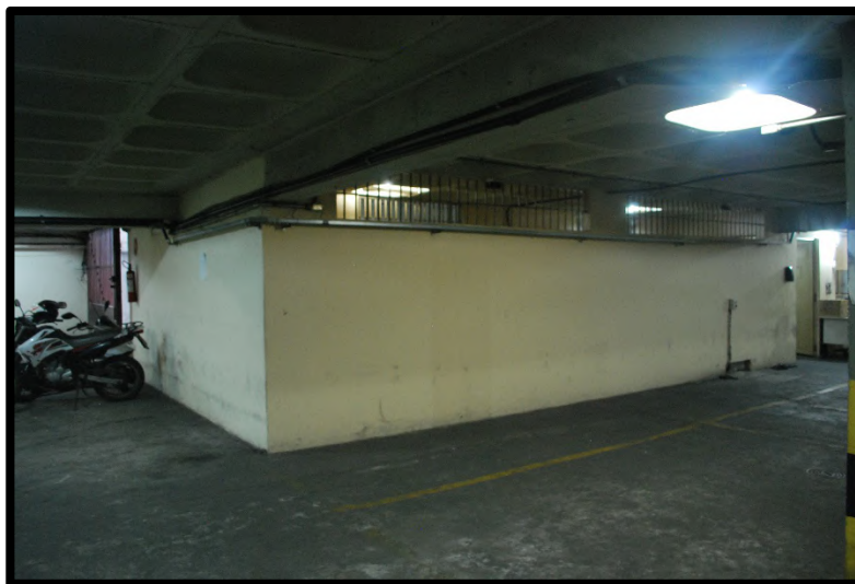
Figura 215 – Parte externa dos alojamentos
