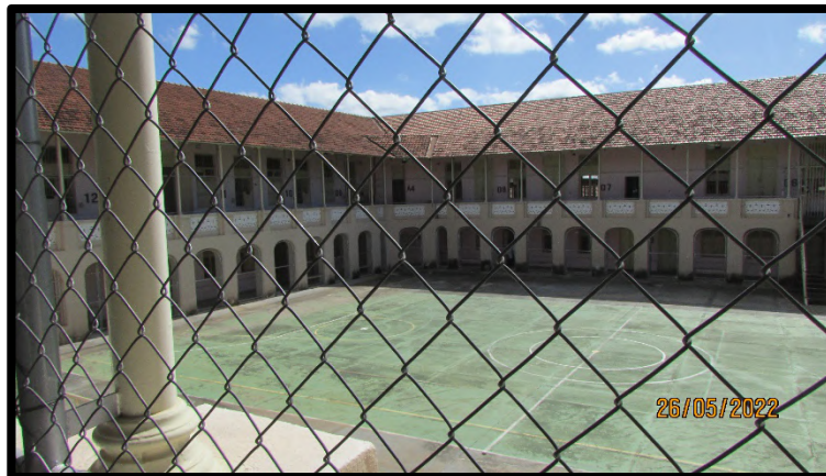
Figura 144 – Estrutura principal (Anexo I)
