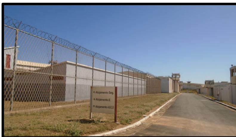
Figura 92 – Parte externa da unidade
