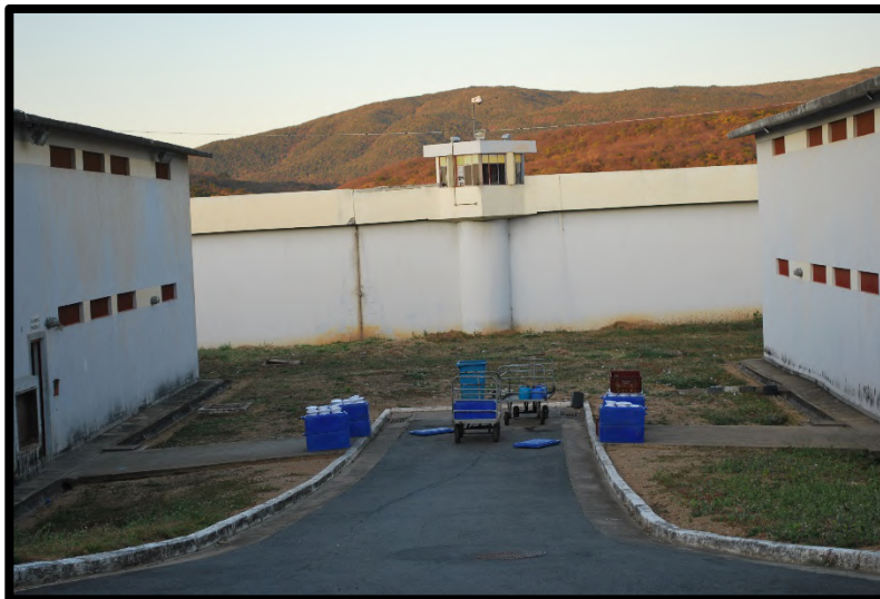
Figura 93 – Parte externa dos pavilhões
