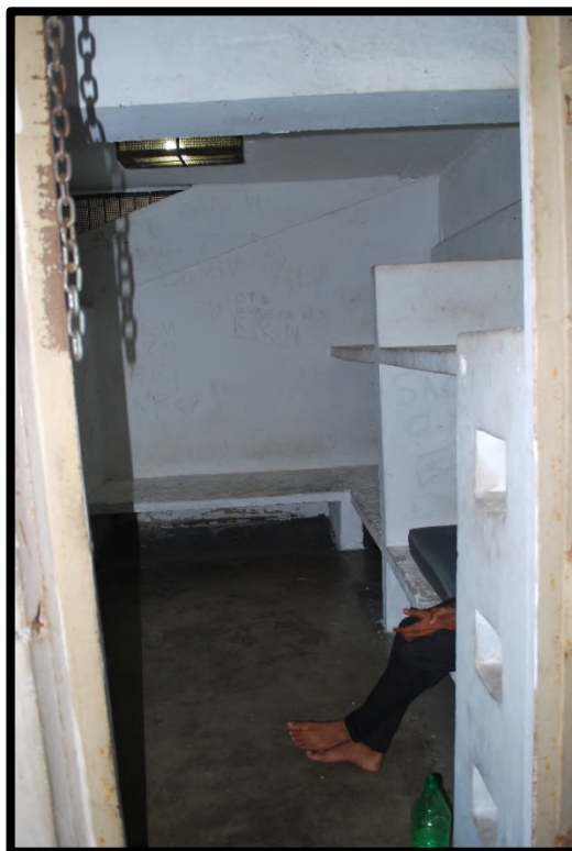
Figura 216 – Estrutura interna do alojamento
