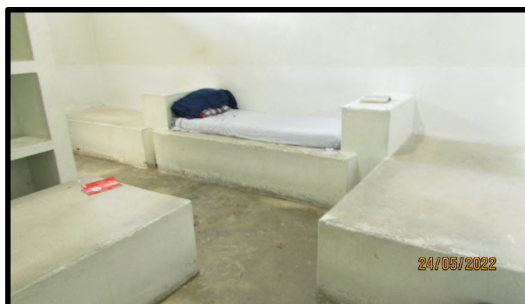
Figura 198 – Estrutura interna do alojamento 1
