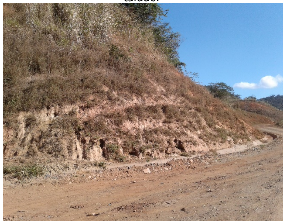
Figura 3.9-05: Ponto 47 (próximo ao Setor 04) com solo exposto e processos erosivos na “saia” do talude.
