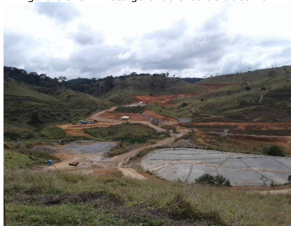
Figura 3.9-02: Vista geral da área de trabalho.
