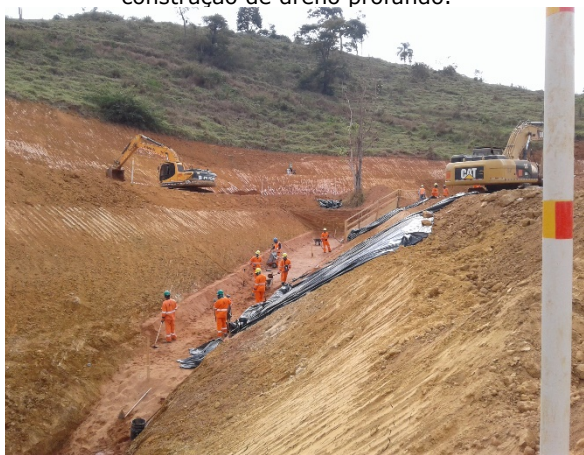
Figura 3.9-01: Terraplenagem Pilha 01 e construção de dreno profundo.
