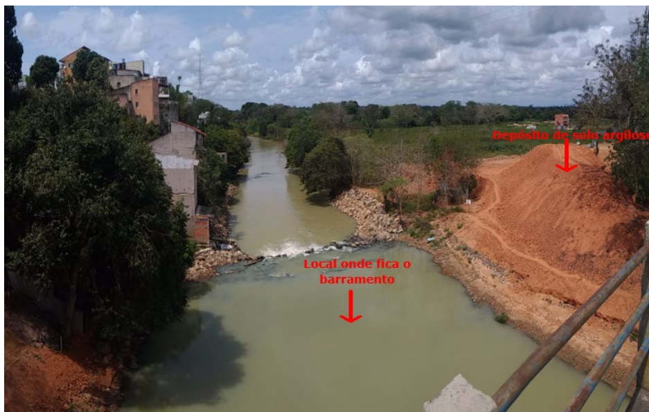
Figura 3.23-04: Vista panorâmica da enseadeira no rio Pequeno – Linhares/ES.
