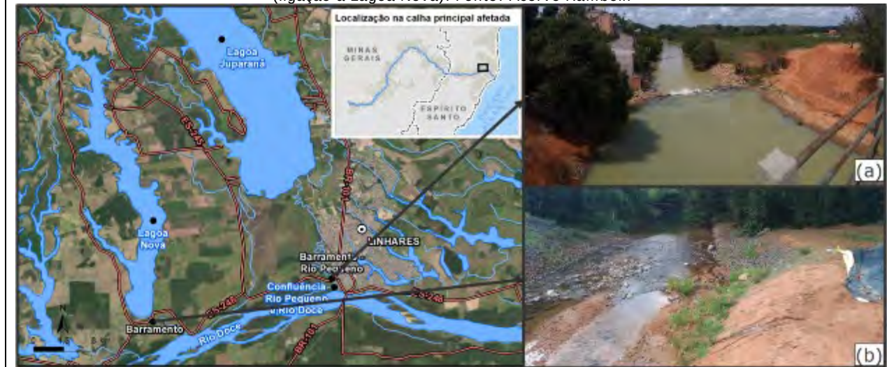
Figura 3.23-09: Localização dos barramentos do (a) rio Pequeno (ligação à Lagoa Juparanã) e do (b) rio Bananal (ligação à Lagoa Nova). Fonte: Acervo Ramboll.
