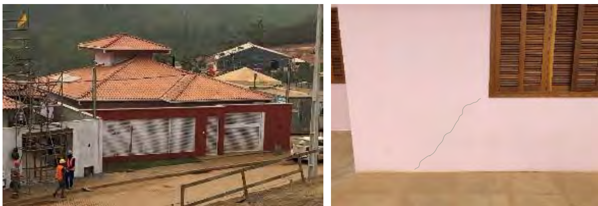
Figura 3.8-04: Trincas identificadas/em correção nos muros de divisa da casa de ID62 do reassentamento de Bento Rodrigues
