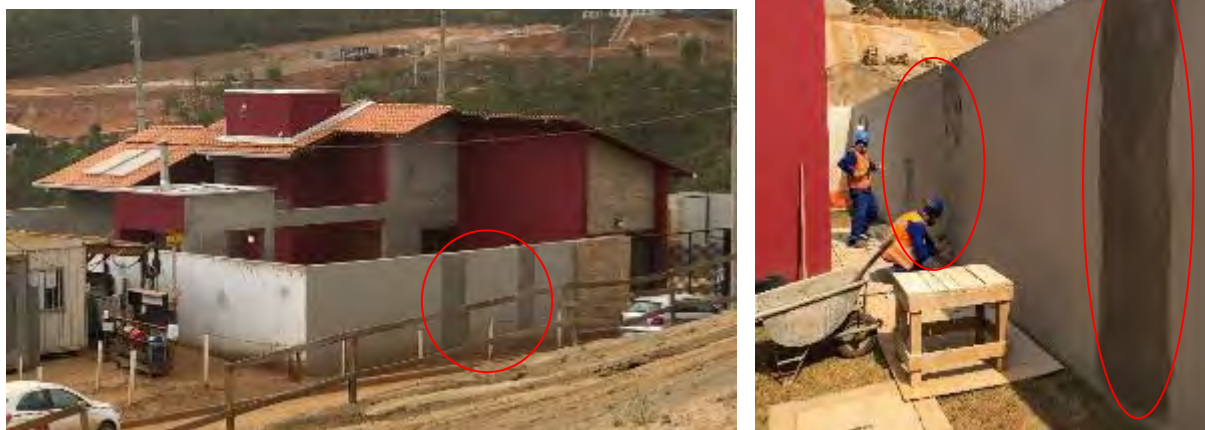
Figura 3.8-04: Trincas identificadas/em correção nos muros de divisa da casa de ID62 do reassentamento de Bento Rodrigues
