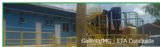
Figura 5.31-09: Implementações de melhorias nas ETAs.
