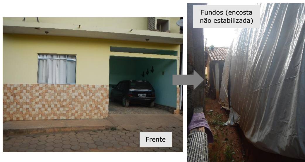
Figura 2.5-03: Moradias temporárias alugadas pela Fundação Renova em Barra Longa (maio/2018)
