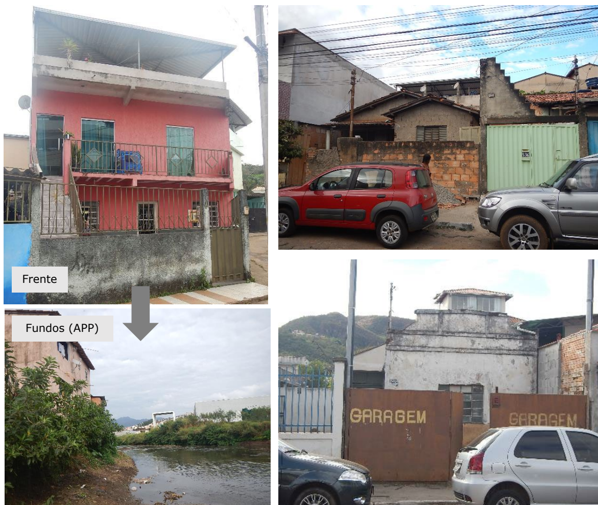
Figura 2.5-01: Moradias temporárias alugadas pela Fundação Renova em Mariana (junho e julho/2018).
