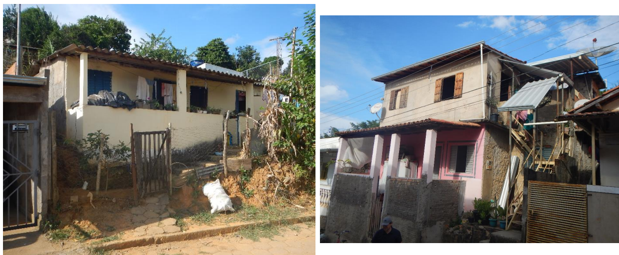
Figura 2.5-02: Moradias temporárias alugadas pela Fundação Renova em Barra Longa (maio/2018).
