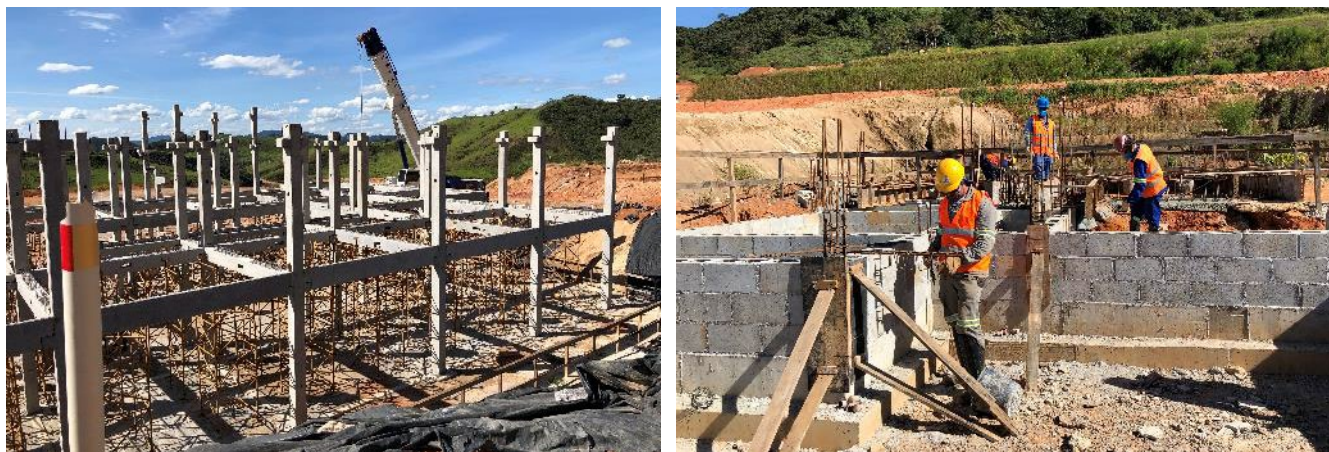
Figura 2.8-06 e Figura 2.8-07: Montagem da estrutura da escola (esquerda) e execução de fundação de uma das edificações do reassentamento de Paracatu de Baixo (Direita).
