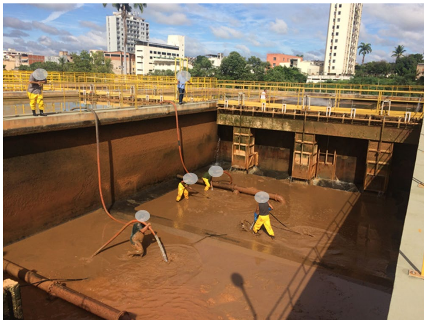
Figura 7: Fotos limpeza do decantador SAAE de Governador Valadares- ETA Central no dia 12/12/18 (Fonte: Ramboll, 2018)
