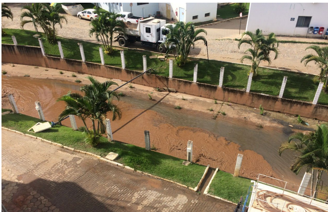
Figura 9: Fotos do ponto de descarte do resíduo de limpeza dos decantadores da ETA Central no dia 12/12/18 (Fonte: Ramboll, 2018)
