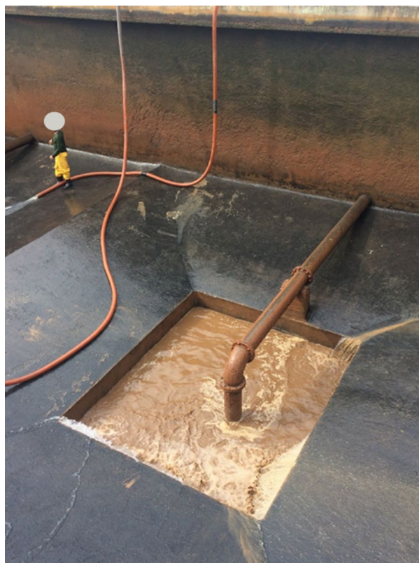
Figura 8: Fotos do fundo do decantador SAAE de Governador Valadares- ETA Central após limpeza no dia 12/12/18 (Fonte: Ramboll, 2018)
