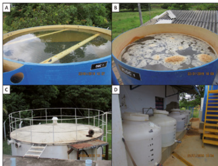
Figura 160 – ETA do distrito de São Vitor: (A) Decantador circular; (B) Tanque de floculação; (C) Tanque de contato e (D) Armazenamento dos produtos químicos para tratamento de água.
