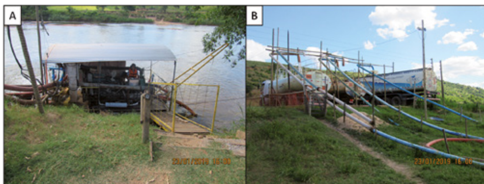
Figura 183 – Instalação emergencial de captação no rio Manhuaçu: (A) Flutuante de bombeamento e (B) Carregamento dos caminhões-pipa.
