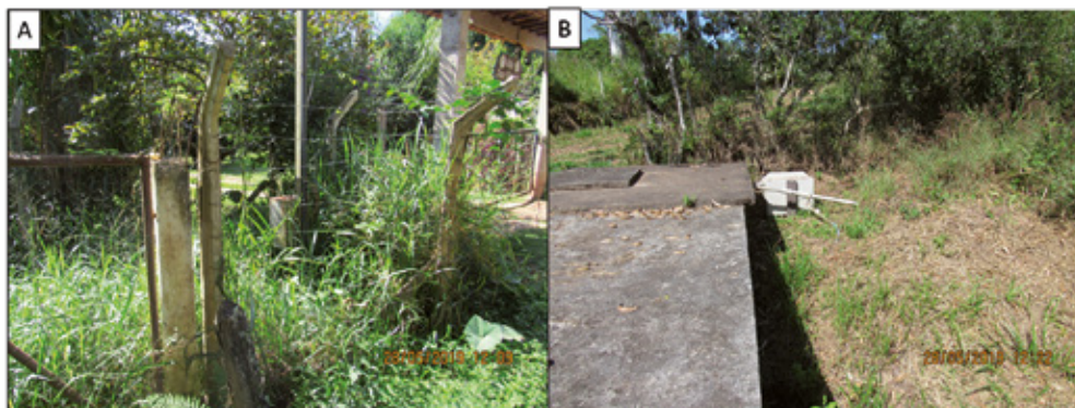
Figura 216 – Poço e reservatório de água utilizados no SAA de água de Camargos, no município de Mariana – MG. A- Poço antigo utilizado para o abastecimento da população de Camargos. B – Reservatório de água.
