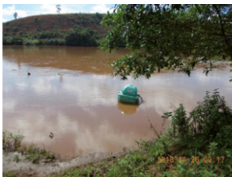
Figura 117 - Detalhe da balsa de captação superficial de água localizada no rio Doce.
