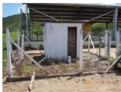
Figura 225 – Instalações externas de proteção do poço tipo cacimba desativado para uso pelo distrito.
