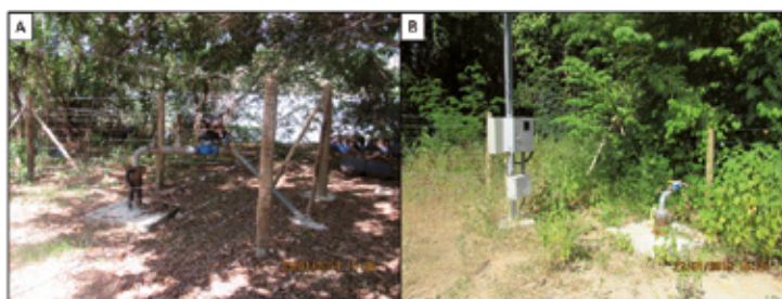
Figura 187 – Captações subterrâneas: (A) Poço C-01 e (B) Poço C-02
