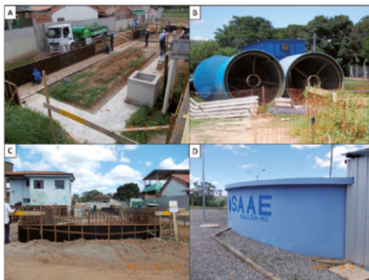
Figura 168 – Instalações da construção da nova ETA em Galileia – MG. A – Espaço da nova ETA para disposição de lixo gerado. B – Componentes da ETA modular. C – Canteiro de obra da nova ETA. D – Novo reservatório construído.
