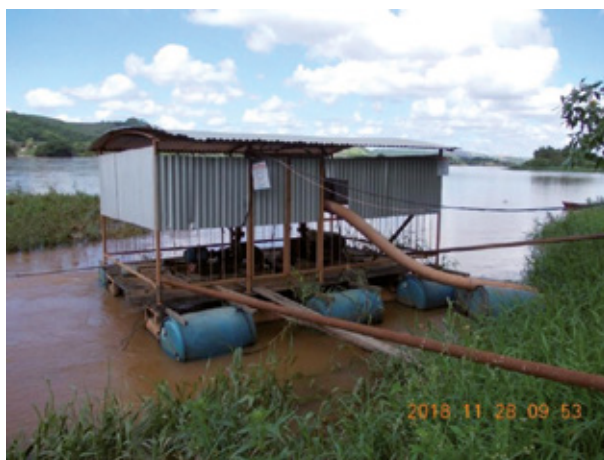
Figura 164 – Local de captação de água bruta no rio Doce para tratamento na ETA de Galileia.
