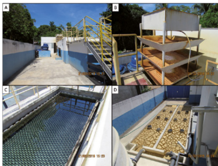
Figura 214 - Instalações da ETA de Regência – ES. A – Visão externa da ETA. B – Sistema de aeração e de adição de cal como pré-tratamento. C – Tanque de decantação. D – Local de secagem do lodo.
