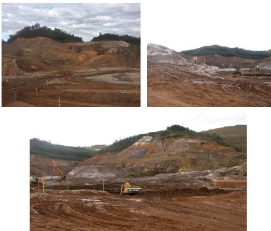
Figura 276 – Imagens do interior da Barragem de Fundão após o rompimento com onde as estruturas geológicas estão obliteradas em função de obras na região e remanescentes de rejeitos.
