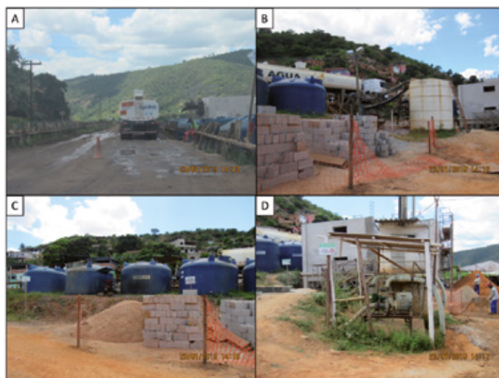
Figura 180 – Instalações Emergenciais: (A) Caminhão-pipa com água bruta; (B) Desabastecimento de água bruta; (C) Sistema provisório de reservação e (D) Bomba elevatória do sistema de reservação à ETA.
