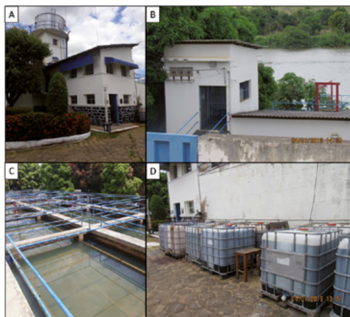
Figura 192 - Instalações da ETA Sede em Baixo Guandú – ES. A – Visão externa da ETA. B – Visão distante do local de captação no rio Doce. C – Decantadores. D – Bombona de coagulante.
