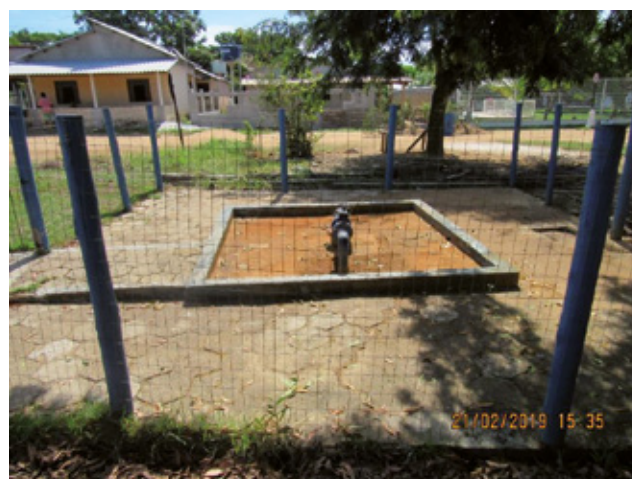
Figura 213 – Vista do poço de propriedade da SAAE Linhares e recuperado pela Fundação Renova para possível abastecimento de água do distrito de Regência.
