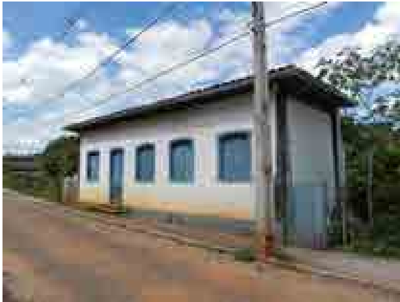
Figura 5: Vista da fachada do bem, evidenciado a sua implantação na rua e o impacto visual do poste e fios na apreensão de sua fachada.
