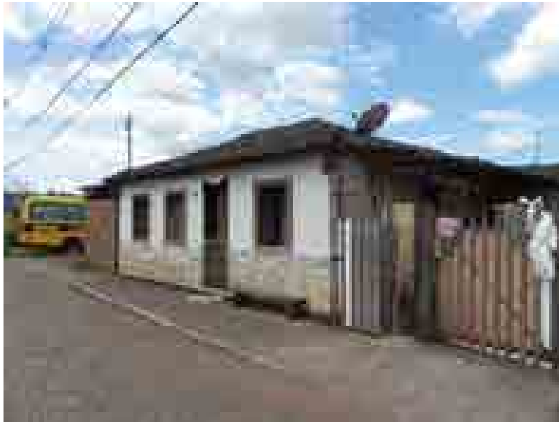
Figura 5: Vista da fachada do bem, evidenciando a passagem de veículo pesado na rua lateral.
