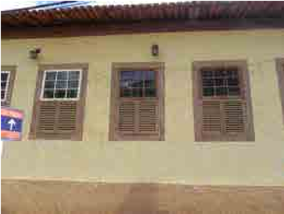
Figura 5: Detalhe da Fachada do bem.
