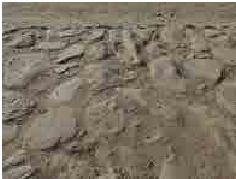
Figura 166 – Calçamento em São Gonçalo Beira Rio, Serro/MG. Percebe-se, no alto da imagem, a instalação das lajes cujo objetivo é travar as composições de seixos
