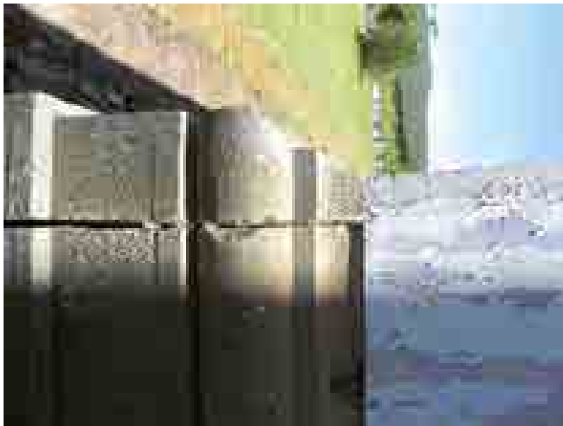
Figura 64 – Descolamento das partes componentes do socio em função de constante trepidação do solo
