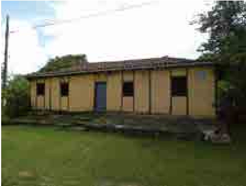
Figura 43 – Residência em Chapada, Ouro Preto/MG
