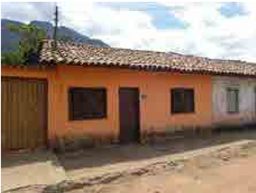
Figura 68 – Edificação na localidade Morro da Água Quente, próximo ao complexo minerador da Samarco Mineração, em Catas Altas/MG
