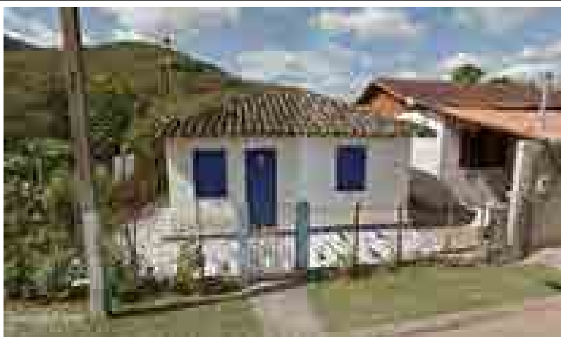
Figura 1: Fotografia do bem em 07/2012. Fonte: Google Earth (2019).
