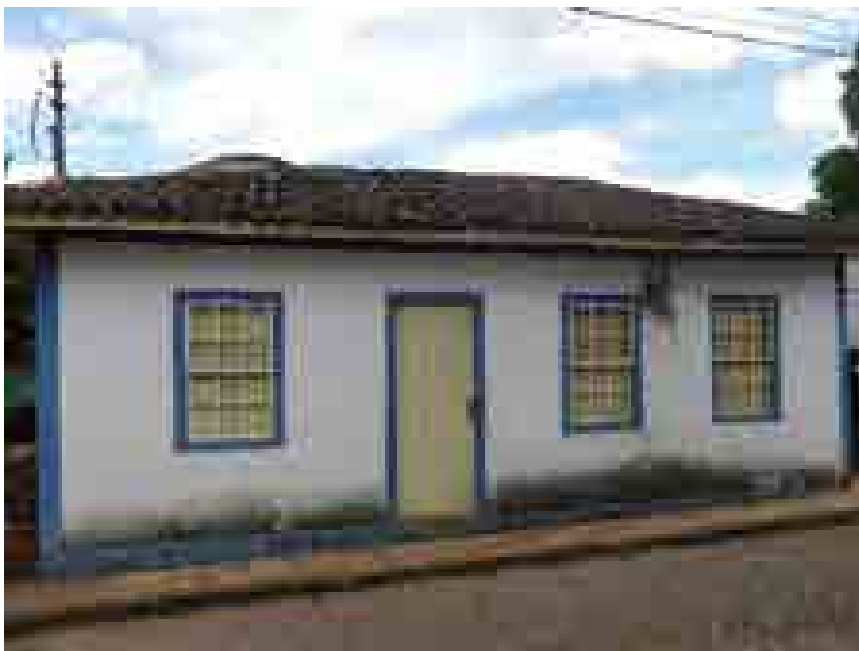
Figura 70 – Edificação de pau a pique em Morro da Água Quente, sem a pressão causada pelo tráfego de caminhões e máquinas pesadas
