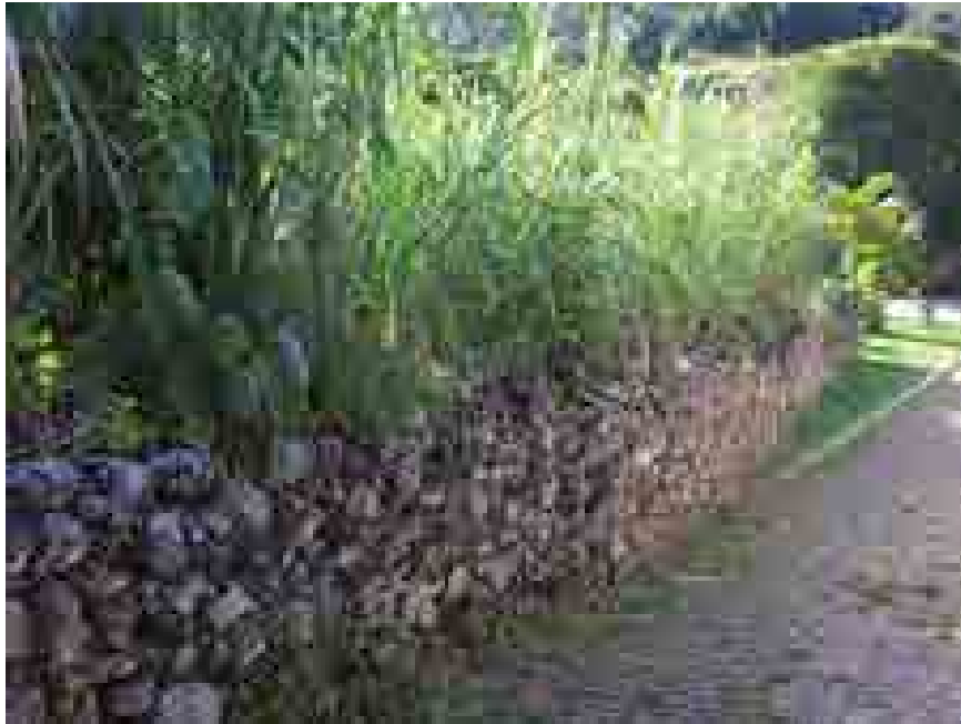
Figura 13 – Muros de pedra canga, assentado com técnica de pedra seca, dividindo lotes em Santa Rita Durão, Mariana/MG
