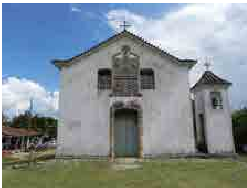
Figura 40 – Igreja de Chapada, Ouro Preto/MG
