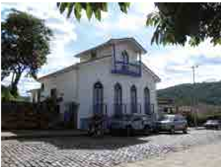
Figura 49 – Centro cultural de Santa Bárbara, a “Casa do Mirante”, revela sua integridade e boa conservação
