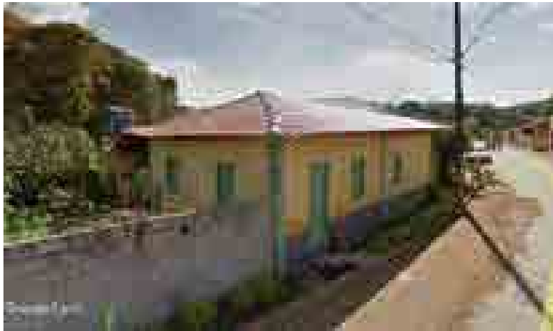
Figura 1: Fotografia do bem em 07/2012. Fonte: Google Earth (2019)
