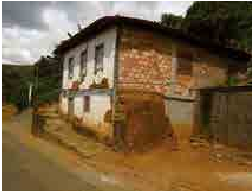
Figura 21 – Edificação no distrito de Furquim, Mariana/MG, construída em pau a pique com uma de suas paredes substituída por tijolos cerâmicos, exemplo recorrente na região
