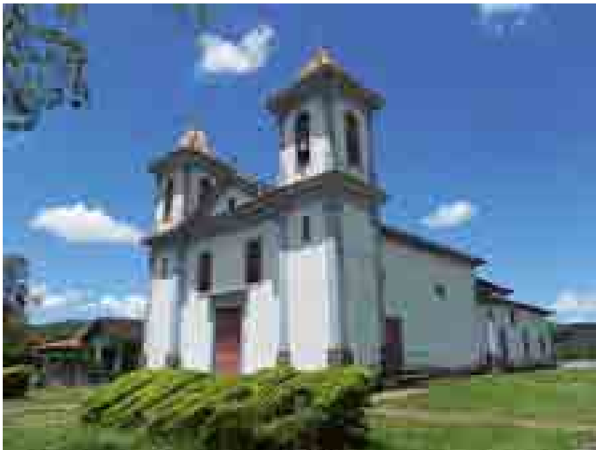
Figura 62 – Igreja Matriz de Santo Amaro, no distrito de Brumal, Santa Bárbara/MG
