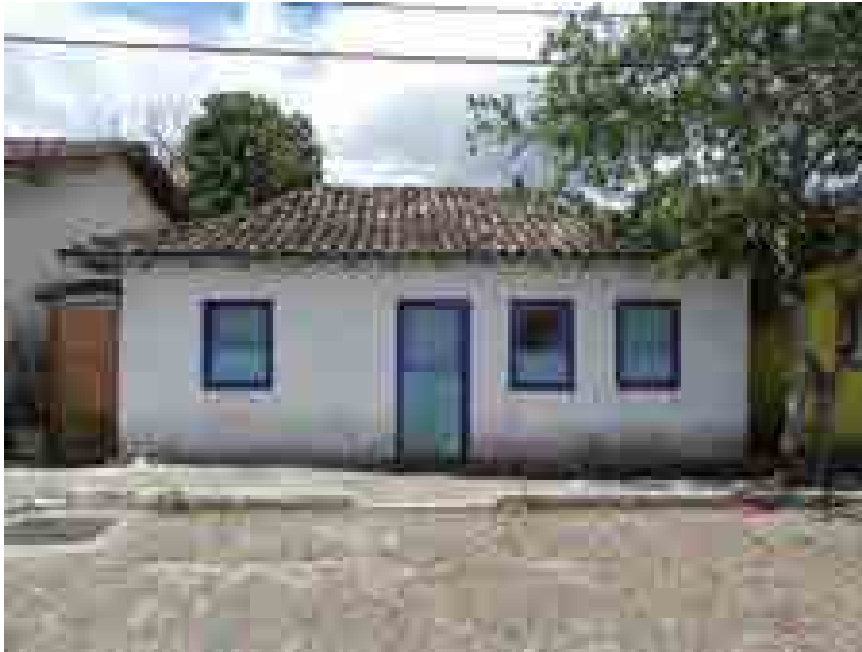
Figura 54 – Residência simples em Lavras Novas, Ouro Preto/MG. A conservação do imóvel não é impecável, porém não se observam problemas estruturais
