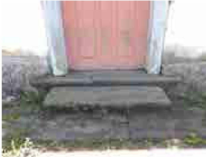
Figura 65 – Rompimento da soleira da porta lateral da Igreja Matriz de Santo Amaro, Brumal, Santa Bárbara/MG
