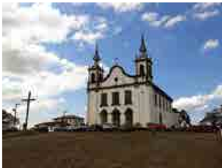
Figura 18 – Igreja Matriz de Nossa Senhora da Conceição, Morro da Água Quente, Catas Altas/MG
