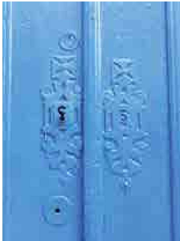
Figura 2 – Espelhos de fechaduras em casa de partido colonial em Barra Longa, na Rua Matias Barbosa, nº 7
