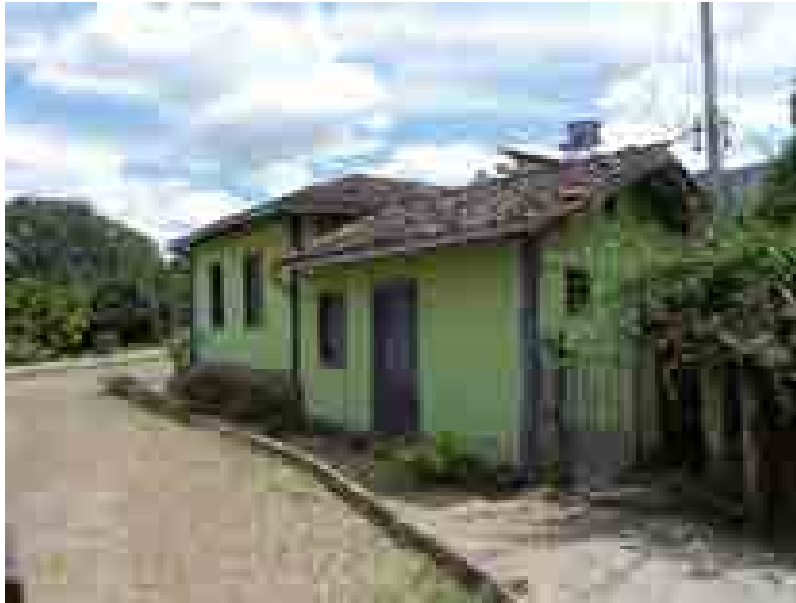
Figura 69 – Edificação na mesma localidade, mas distantes do tráfego de caminhões
