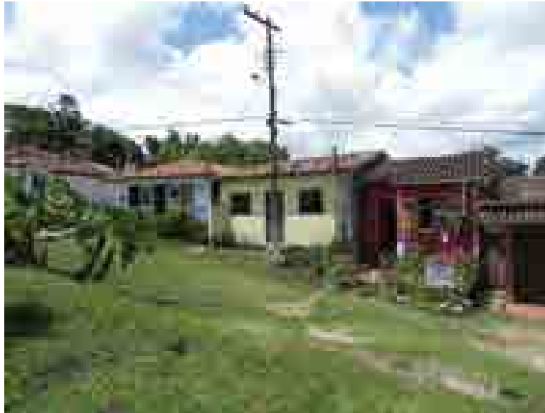
Figura 56 – Conjunto de edificações em Lavras Novas, Ouro Preto/MG. Apesar do uso intensivo para as atividades associadas ao turismo não são observáveis problemas estruturais nas edificações
