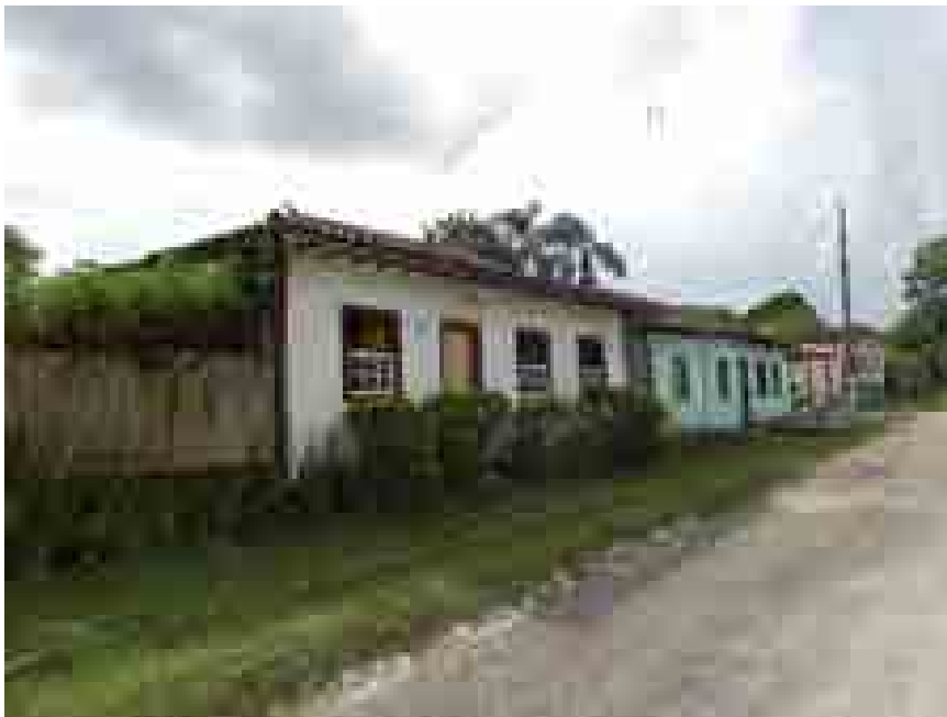
Figura 42 – Conjunto de residências em Chapada, Ouro Preto/MG
