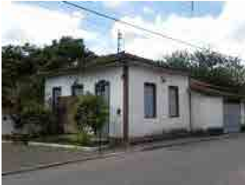
Figura 5: Vista da lateral do bem.
