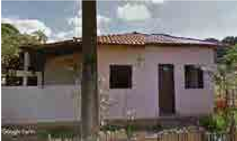
Figura 7. Fotografia da edificação ao lado da escada em 06/2012. Fonte: Google Earth (2019).
