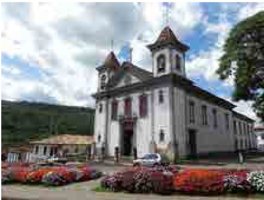
Figura 47 – Igreja Matriz de Santo Antônio, Santa Bárbara/MG
