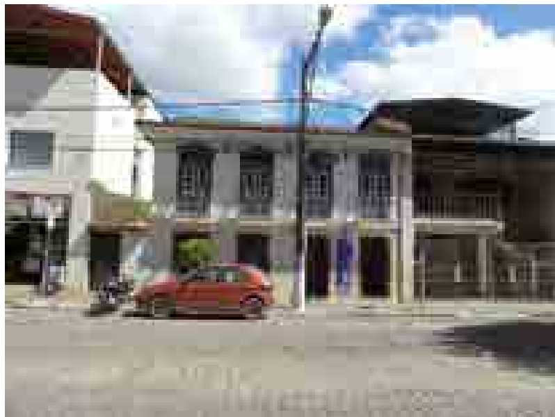
Figura 5: Vista da fachada do bem, mostrando sua implantação na rua. Nota-se o impacto visual do poste e da fiação para a apreensão visual do bem.
