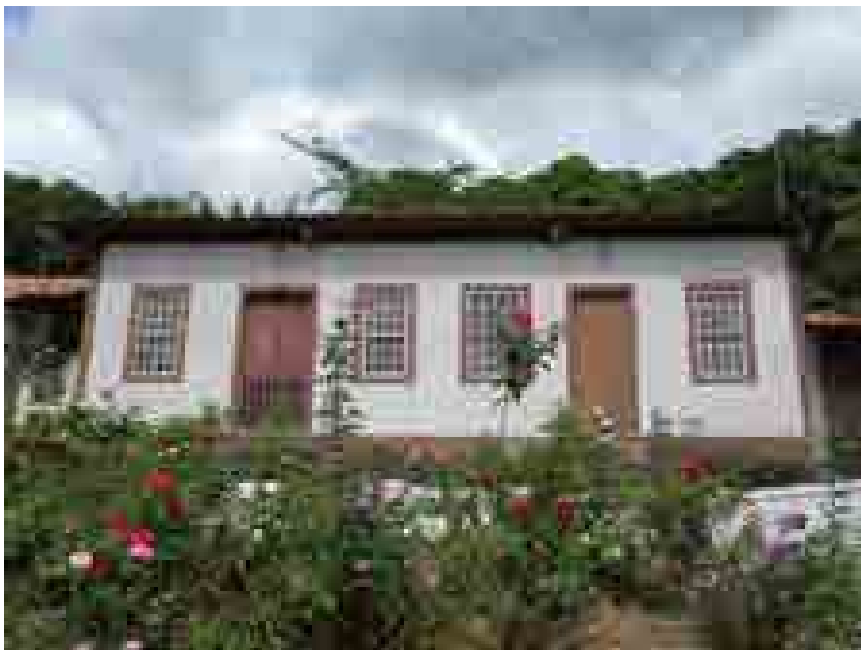
Figura 61 – Outra construção térrea em Furquim, Mariana/MG. Situação análoga a anterior da Figura 60
