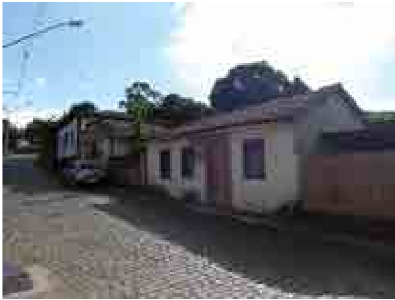
Figura 7: Vista da fachada do bem e sua implantação na rua.
