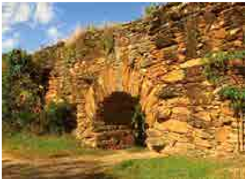
Figura 156 – Arco do Bicame de Pedra, estrutura de 1792 próximo a Santa Bárbara
