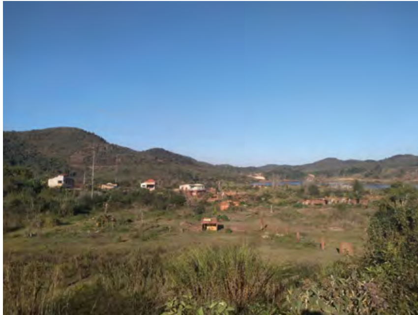
Figura 47 – Vista parcial da área atingida pela onda de rejeitos Bento Rodrigues. Registro em 12/08/2018. Bento Rodrigues, Mariana (MG).
