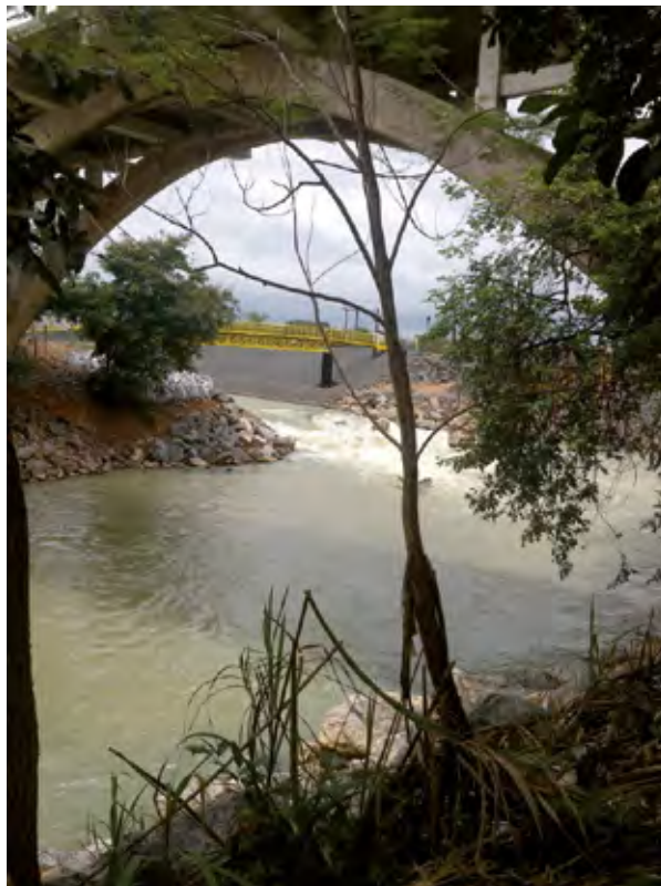
Figura 120 – Vista das obras de abertura do dique de contenção do rio São José a partir da rua Beira Rio. Registro em 05/11/2018. Sede, Linhares (ES).
