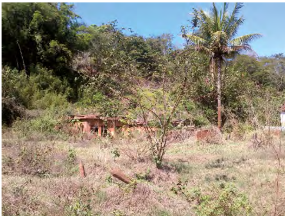
Figura 18 – Edificações em área atingida pela onda de rejeitos em Gesteira. Registro em 11/08/2018.
