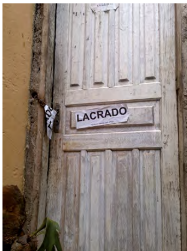
Figura 121 – Detalhe de casas lacradas na rua Beira Rio, moradores foram retirados devido ao risco de alagamento e desmoronamento pelas obras de abertura do dique de contenção no rio São José. Registro em 05/11/2018. Sede, Linhares (ES).
