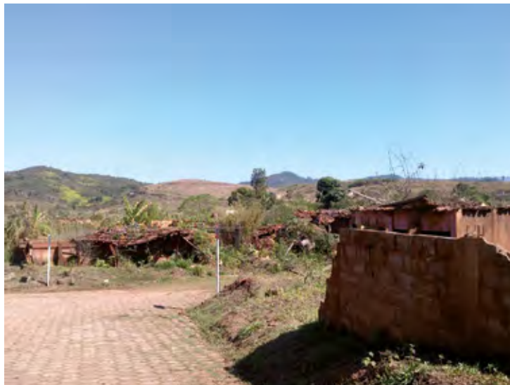
Figura 48 – Edificações danificadas pela onda de rejeitos em Bento Rodrigues. Registro em 12/08/2018. Bento Rodrigues, Mariana (MG).
