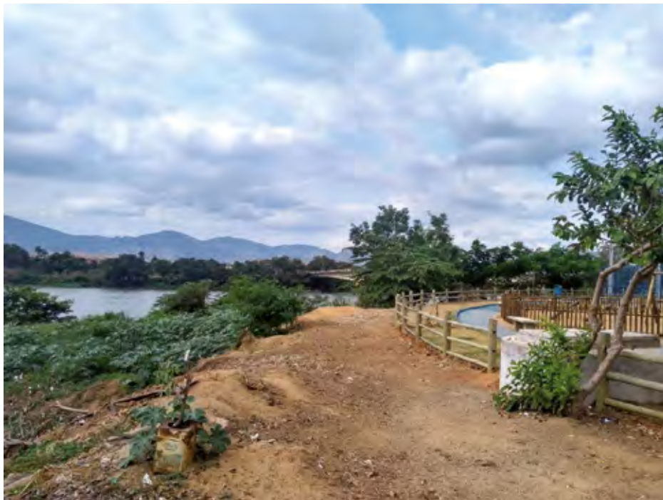
Figura 149 – Parte da estrutura da Praça da Mauá e Rio Doce. Registro em 05/10/2018. Sede, Baixo Guandu (ES).
