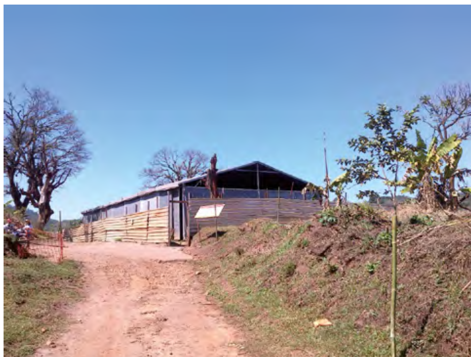
Figura 41 – Isolamento da área da Capela de São Bento. Registro em 12/08/2018. Bento Rodrigues, Mariana (MG).
