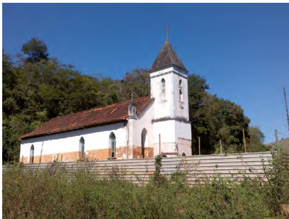
Figura 39 – Igreja Nossa Senhora da Conceição, isolada por tapumes. Registro em 11/08/2018. Gesteira, Barra Longa (MG).
