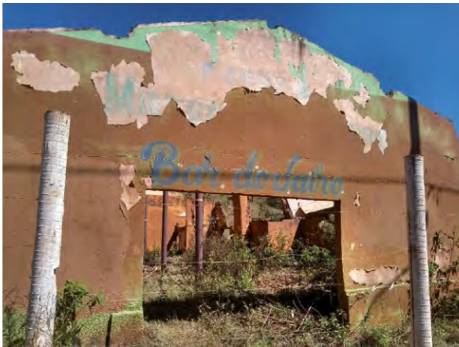
Figura 9 – Ruínas do Bar do Jairo, em Paracatu de Baixo, atingido pela onda de rejeitos. Registro em 11/08/2018. Paracatu de Baixo, Mariana (MG).
