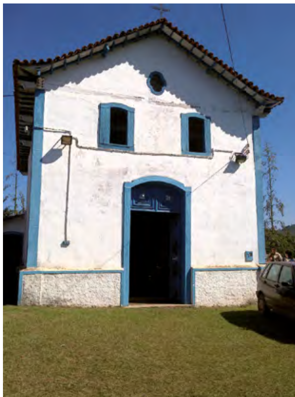
Figura 26 – Igreja de Nossa Senhora das Mercês em Bento Rodrigues. Registro em 12/08/2018. Bento Rodrigues, Mariana (MG).
