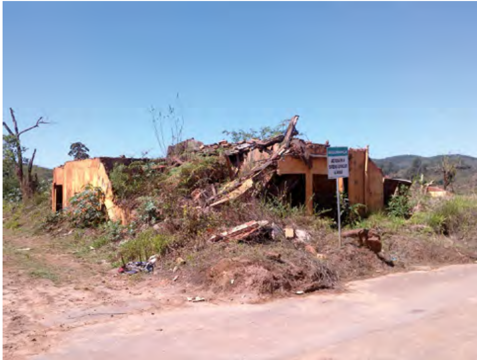
Figura 3 – Detalhe das ruínas da Escola Municipal de Bento Rodrigues. Registro em 12/08/2018. Bento Rodrigues, Mariana (MG).
