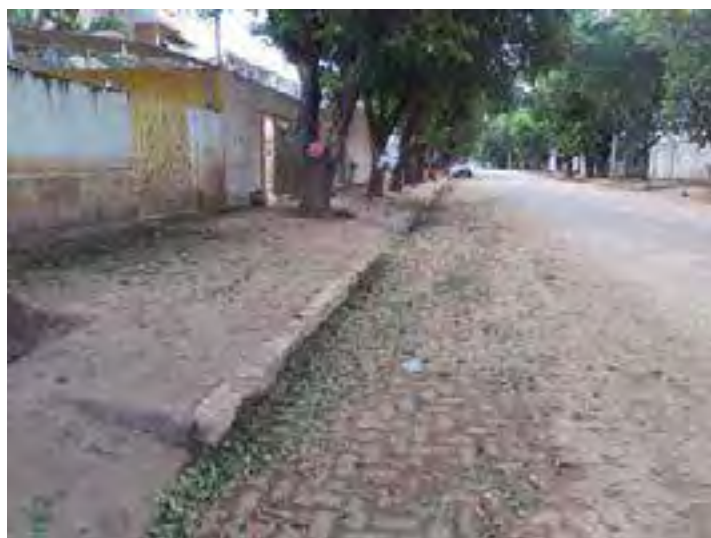
Figura 301 – Altura da marca de água na Avenida Mucuri, no bairro Ilha dos Araújo, em Governador Valadares, no dia 19/02/2020.
