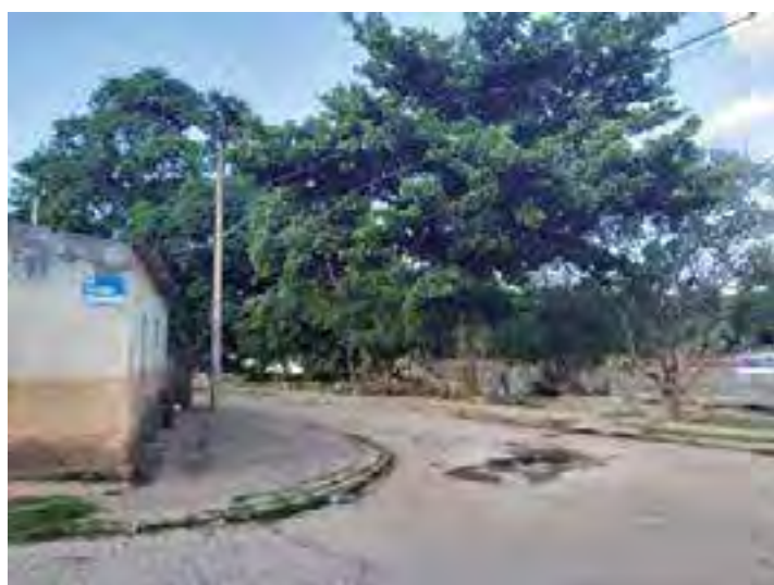
Figura 302 – Altura da marca d'água no muro da residência localizada na esquina da rua Virgílio Gobb com a rua Pascoal de Souza Lima, no bairro Santa Terezinha, em Governador Valadares, no dia 19/02/2020.
