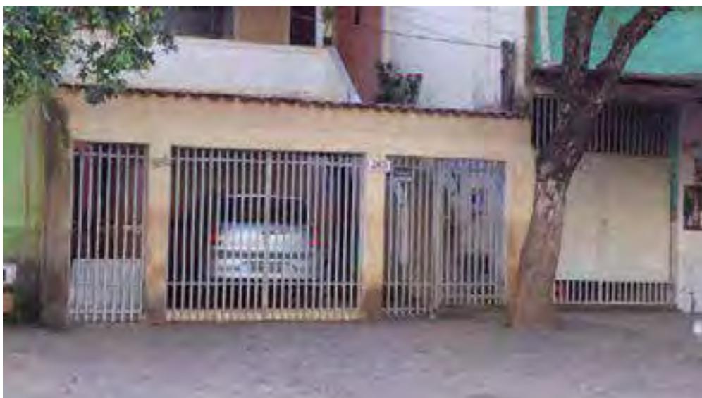
Figura 307 – Altura da marca d'água nas residências da rua Amélia Habib, a uma distância de três quadras da margem do rio Doce no bairro Santa Rita, em Governador Valadares, no dia 19/02/2020.
