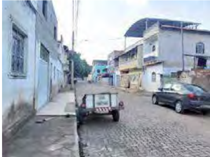
Figura 303 – Altura da marca da água no muro das residências localizadas na rua Virgílio Gobb, no bairro Santa Terezinha, em Governador Valadares, no dia 19/02/2020.
