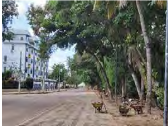
Figura 299 – Equipe da prefeitura trabalhando na Avenida Rio Doce, próximo à praça Caparaó, no bairro Ilha dos Araújo, em Governador Valadares, no dia 19/02/2020.
