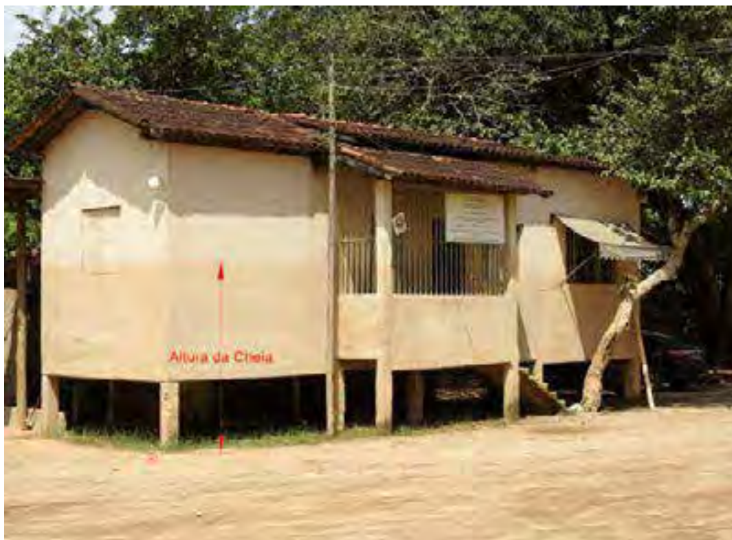
Figura 75 – Marca do pico de cheia em uma edificação no município de Naque – MG.
