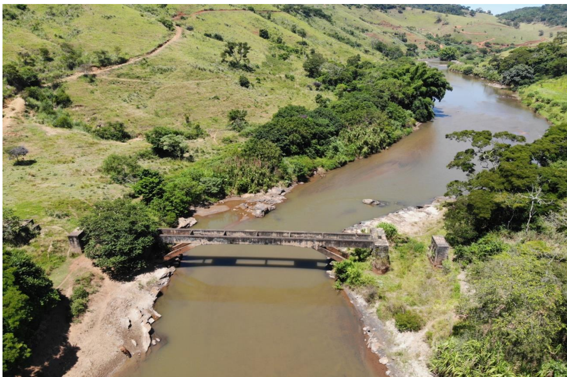
Figura 3 – Vista aérea do Pontilhão da Estrada de Ferro Leopoldina
