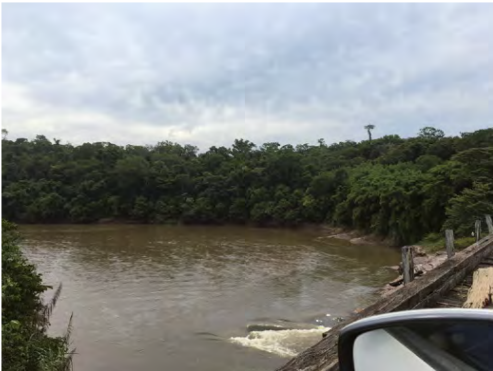
Figura 7. Parque Estadual do Rio Doce (PERD) na 'ponte sobre o rio Doce. Foto tirada em 04/02/2019 às 15:09.
