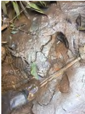
A – Detalhe da presença de rejeito
