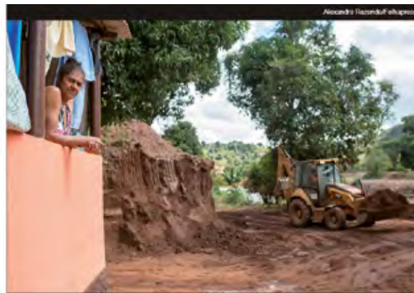
Figura 318 – Moradora da cidade de Barra Longa em 2016, convivendo com a poeira decorrente da lama depositada no Parque de Exposições.
