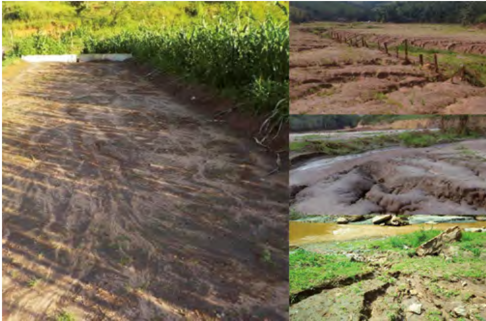
Figura 120 – Registros fotográficos de processos erosivos nas áreas de deposição do rejeito (Compartimento 1).
