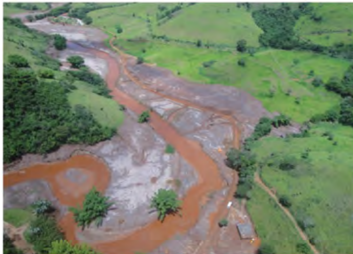
Figura 15 – Margens do rio Gualaxo do Norte com intensa alteração na paisagem em decorrência da passagem e deposição da lama de rejeito.
