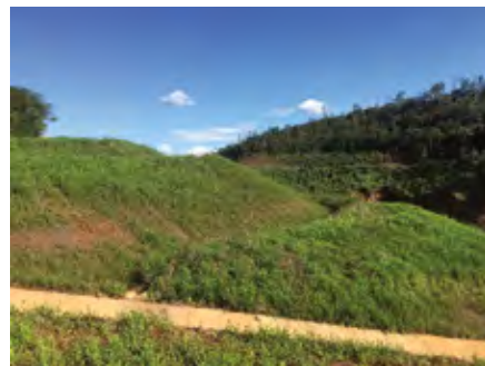
B – Visão geral da região alterada pelas obras
