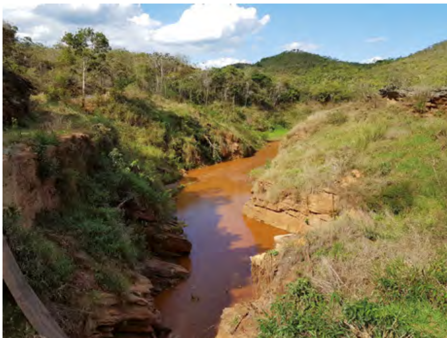
Figura 10 – Exemplo de alteração física na paisagem com remoção da vegetação e solos das margens, além de alteração na coloração e na qualidade da água. Foto de 13/11/2017
