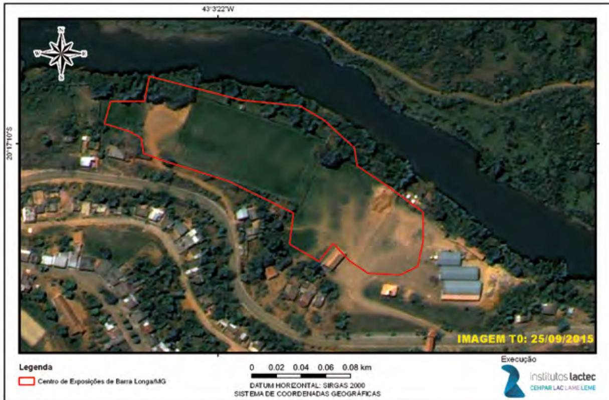
Figura 48 – Imagem T0 (pré desastre) Centro de Exposições de Barra Longa
