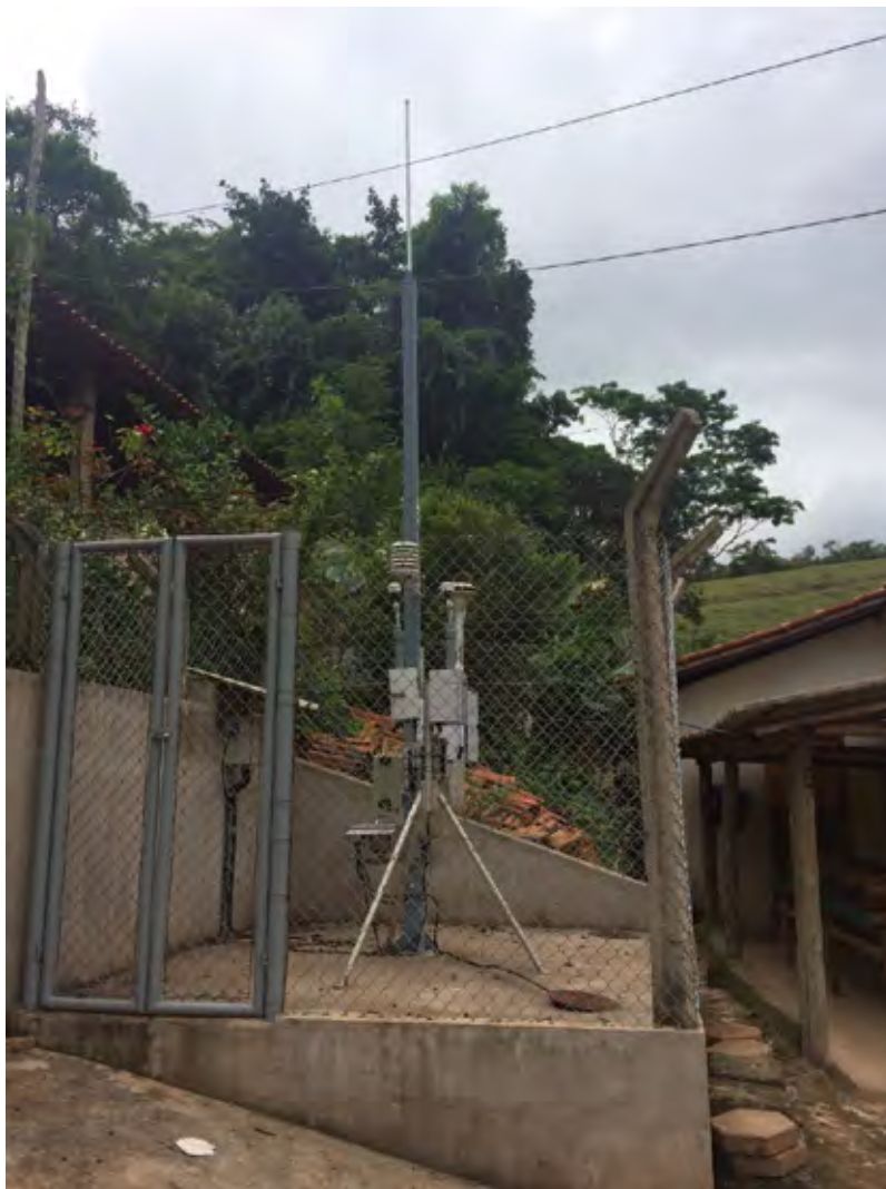
Figura 324 – Estação de monitoramento da qualidade do ar Paracatu
