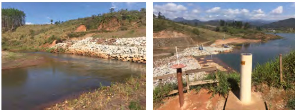
Figura 14 – Alteração na paisagem em decorrência de obras de contenção posteriores ao desastre. À direita, é o reservatório do dique S4, que alagou o entorno do antigo subdistrito de Bento Rodrigues. Foto de 02/10/2018
