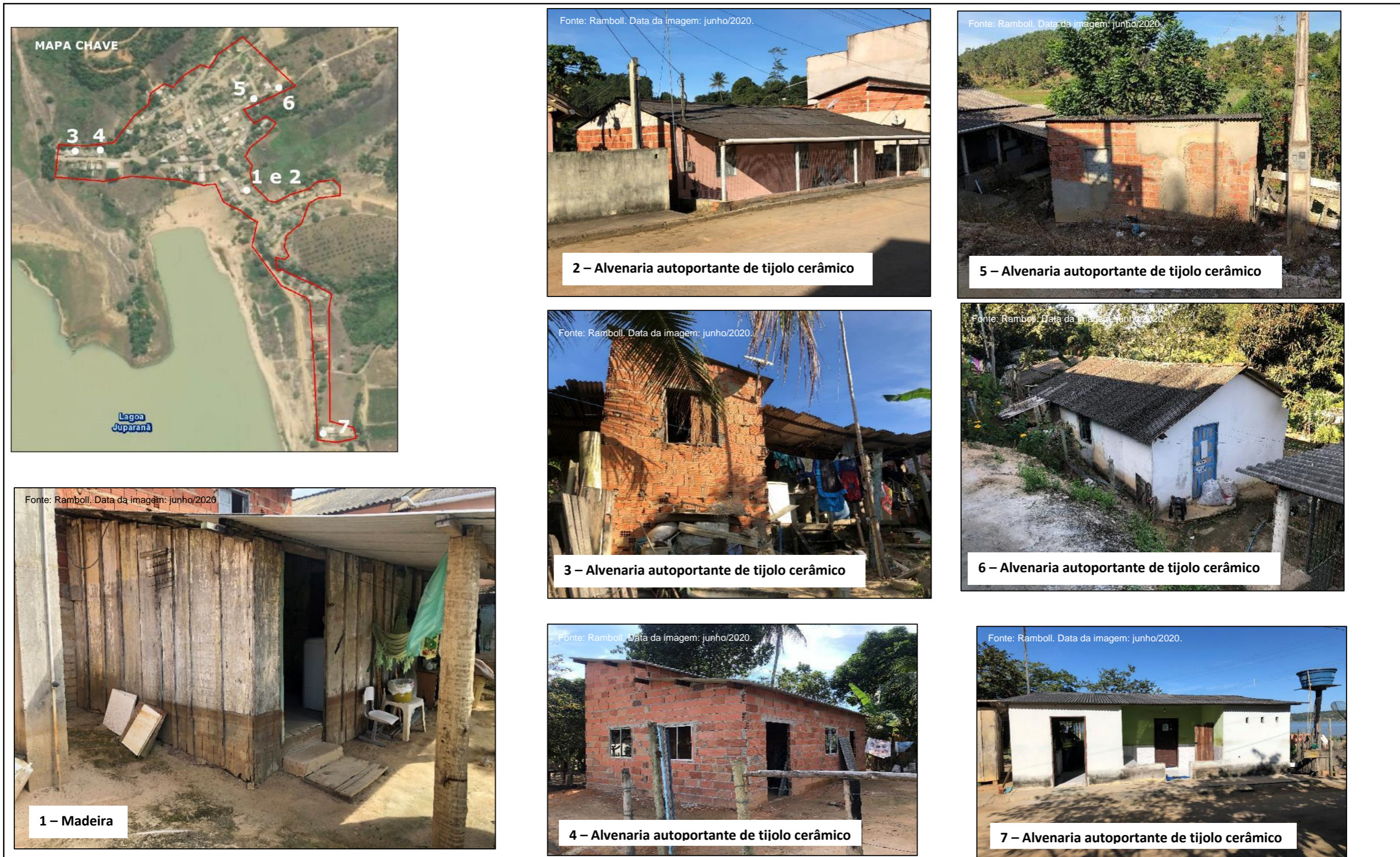
Figura 37 — Formas de manifestação da autoconstrução e as tipologias construtivas encontradas no distrito de Comendador Rafael (Patrimônio da Lagoa)
