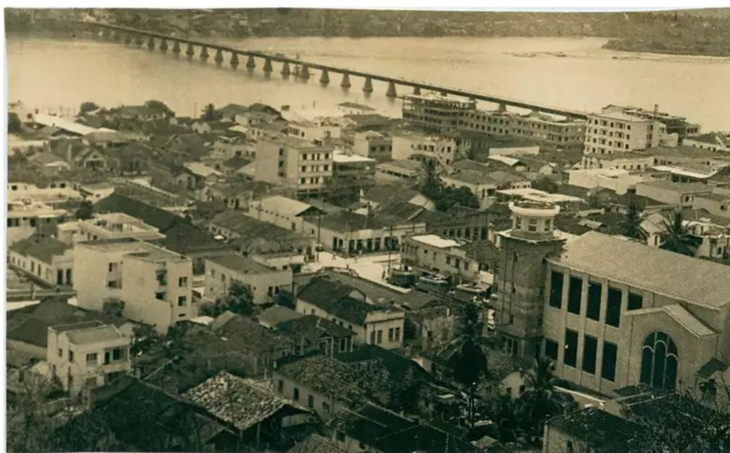
Figura 3 — Registro fotográfico da Ponte Florentino Ávidos sobre o Rio Doce, na cidade de Colatina (ES)
