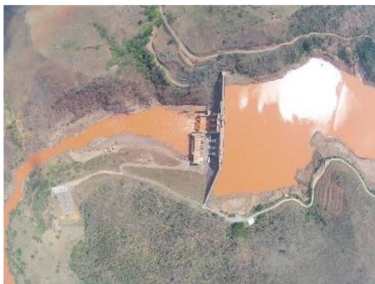
Figura 24 — Imagem área a montante e jusante da barragem da UHE Risoleta Neves de 13 de novembro de 2015
