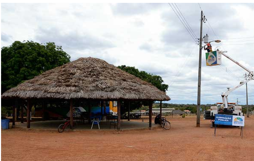
80 luminárias de 70 watts estão sendo instaladas pela equipe de iluminação da Prefeitura de Boa Vista
