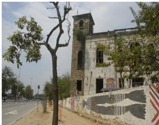
Após pressão da sociedade, o Museu do Índio será preservado, mas os indígenas serão retirados e o prédio abrigará o futuro Memorial Olímpico
