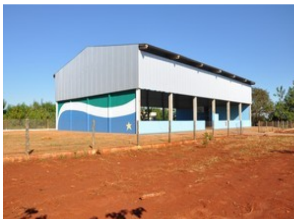
Quadra da Escola Guateka já foi entregue pela empresa construtora ao governo do Estado - Divulgação
