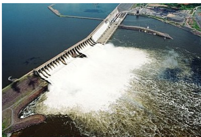
As obras da primeira casa de força de Tucuruí foram concluídas em dezembro de 1992. Foto: Divulgação/Eletronorte
