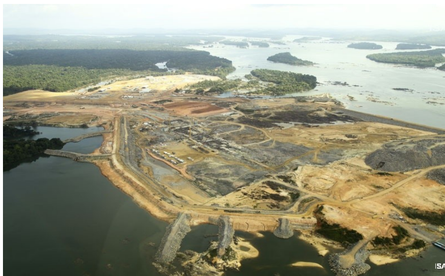
Sítio Pimental, UHE Belo Monte (PA) – obras seguem a todo vapor, Foto: ISA
