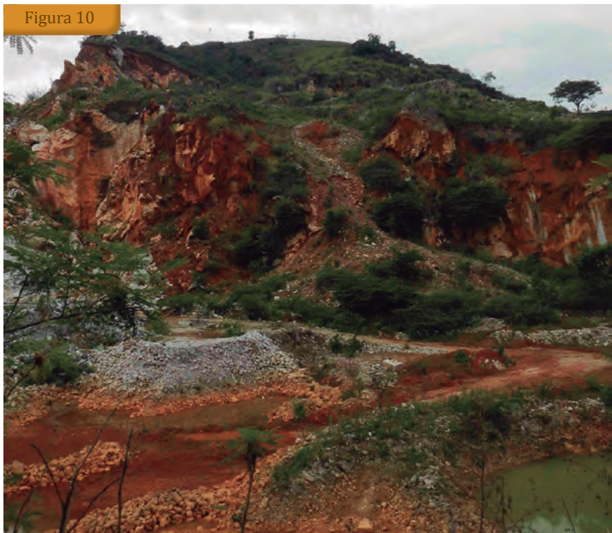
Área de extração de rocha em encosta com alta declividade. Região de Cachoeiro de Itapemirim, sul do Espírito Santo
