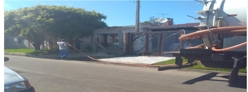
Monitoramento dos tempos de execução
