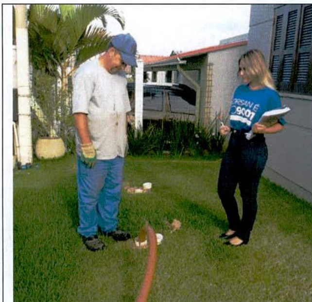
Acompanhamento das Limpezas de Fossas sépticas
