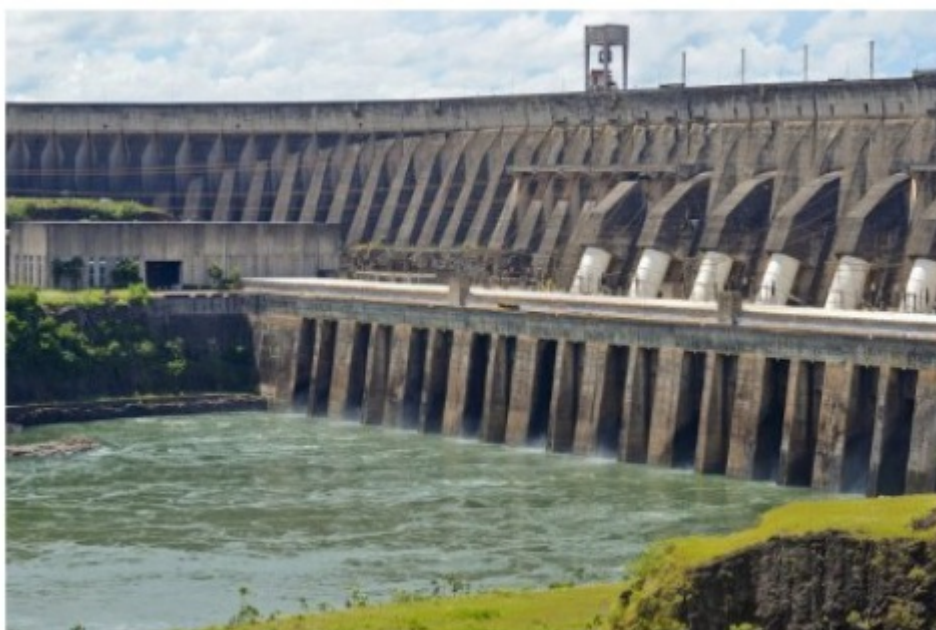
Barragem de Concreto de Itaipu. (Imagem: Flickr)
