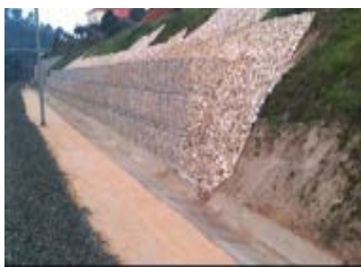
Figura A2.1 B - Talude de um aterro, protegido por gabiões de enrocamento.
