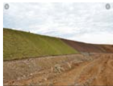
Figura A2.1 C - Talude de um aterro, protegido na parte superior por grama e na inferior por enrocamento.
