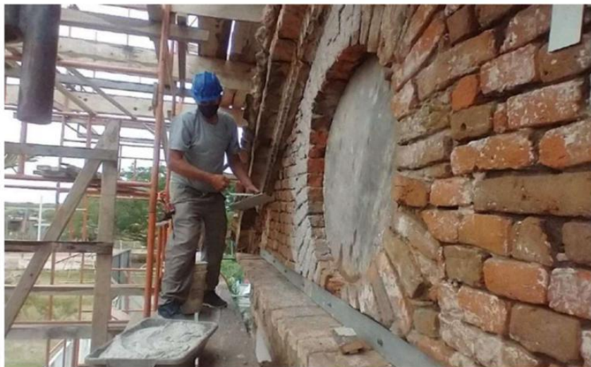
Foto 26 – Chapisco em cal e areia 1:3 para base revestimento.
