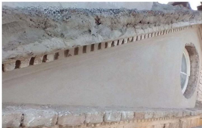
Foto 30 – Revestimento em argamassa cal e areia 1:3 no timpano.
