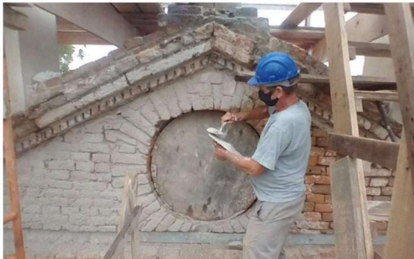
Foto 25 – Chapisco em cal e areia 1:3 para base revestimento.
