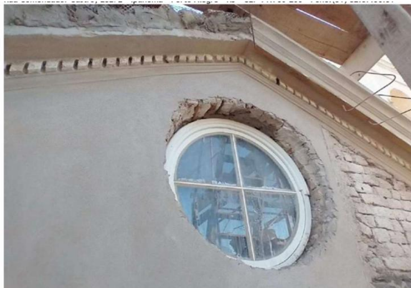
Foto 29 – Revestimento em argamassa cal e areia 1:3 no timpano.
