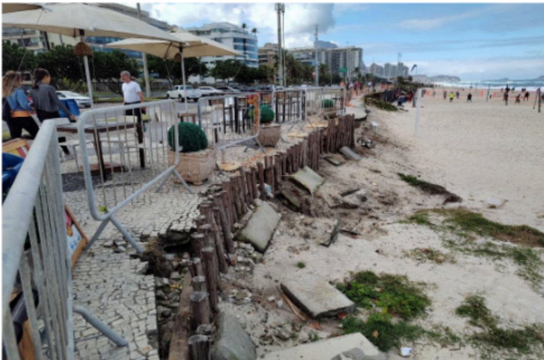
Figura 11: Trecho 08: Calçada destruída pela ressaca em 2020 (21/08/2022).
