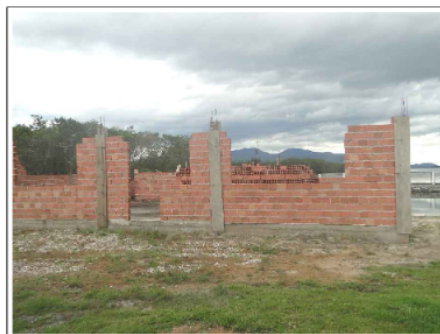
Figura 5 – Edificação em construção.
