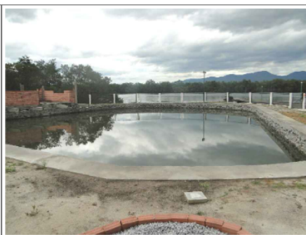
Figura 6 – Vista de tanque próximo à edificação em construção.
