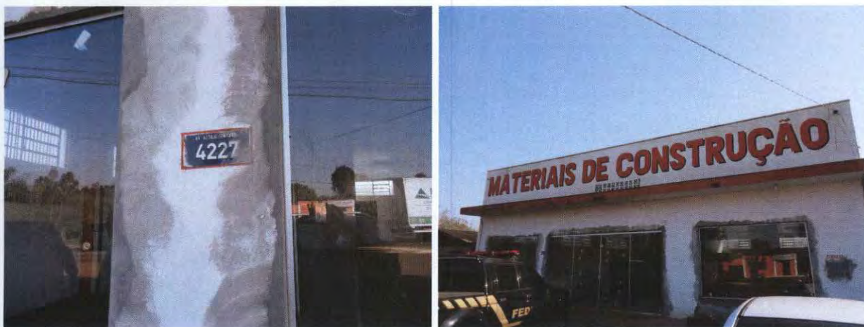
Vista externa do endereço. Na parte superior, loja em reforma.
