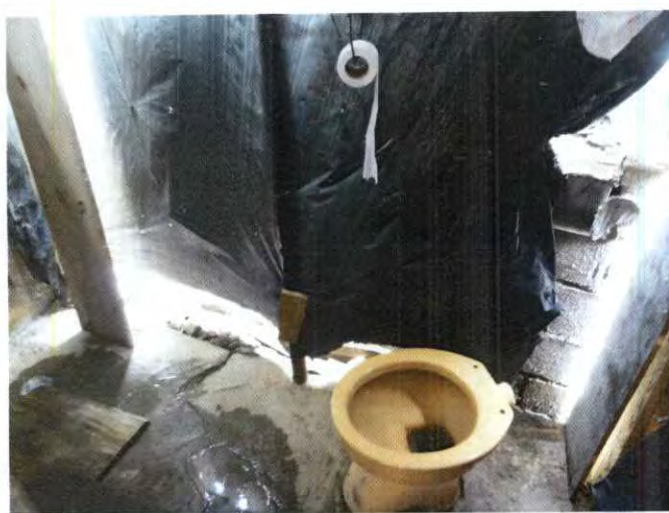
Instalações sanitárias precárias
