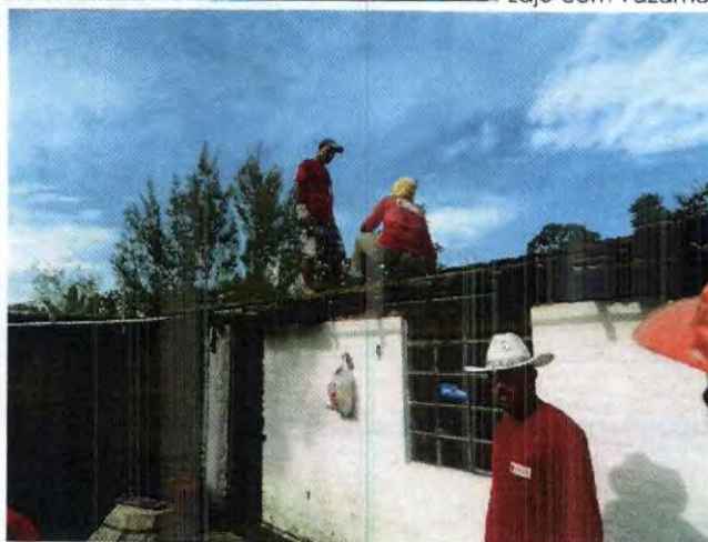
Trabalhadores tentando reparar o telhado do alojamento
