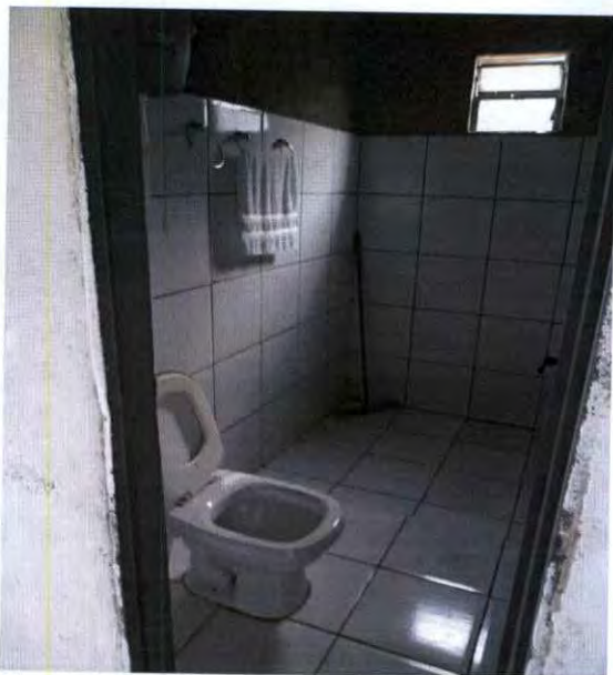
Fig.: Banheiro do interior da casa.
