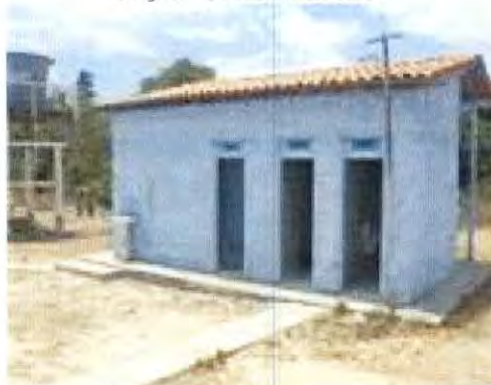
Fig.: Instalações sanitárias.
