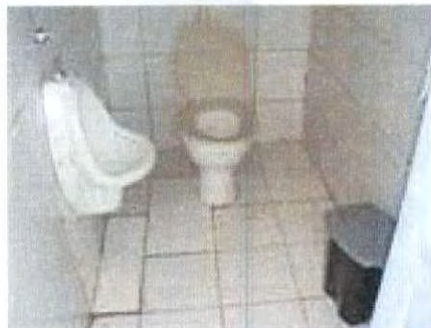
Fig.: Detalhe das instalações sanitárias.
