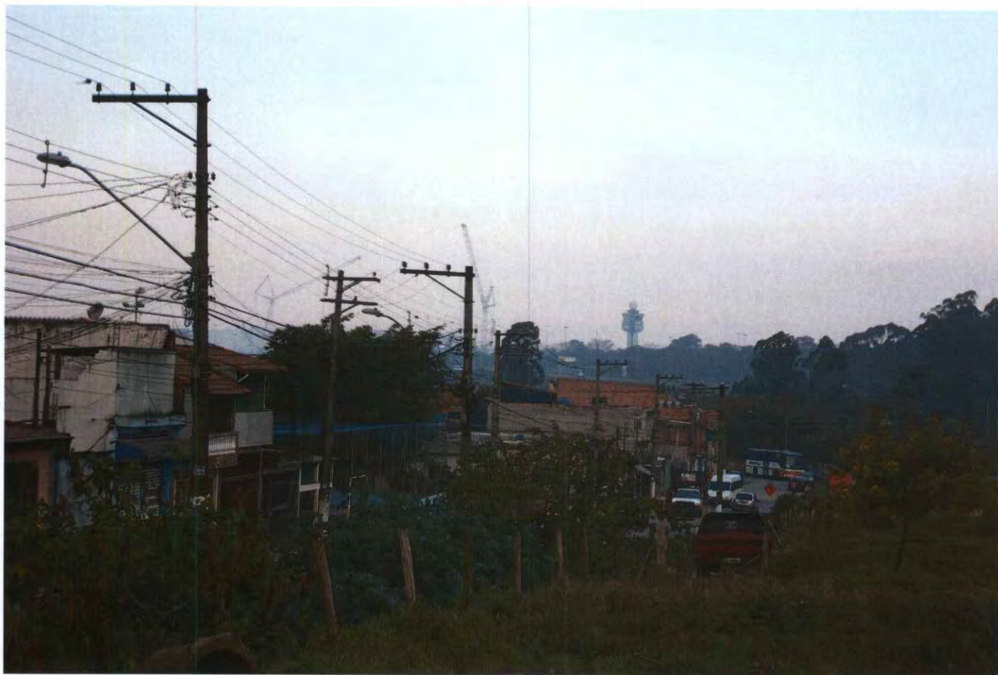
Comunidade no Bairro Santa Lúcia – a cerca de um quilômetro de distância das obras do Aeroporto Internacional de Guarulhos, ao fundo, na foto, torre de comando do aeroporto e gruas das obras de ampliação - local onde os três alojamentos dos trabalhadores submetidos a condição análoga à de escravo foram encontrados.
