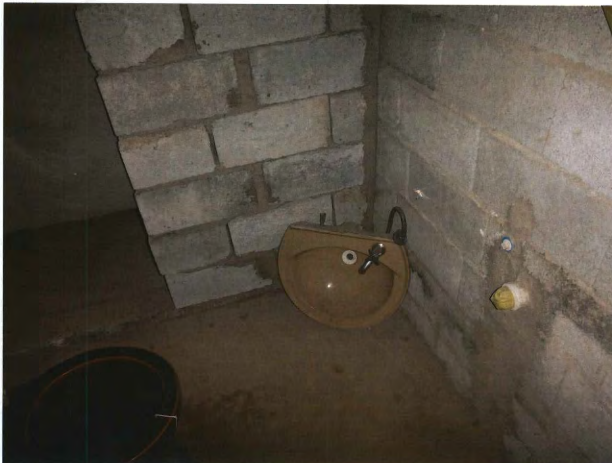
Alojamentos Jardim Lidia e Jardim Malvinas – instalações sanitárias improvisadas
