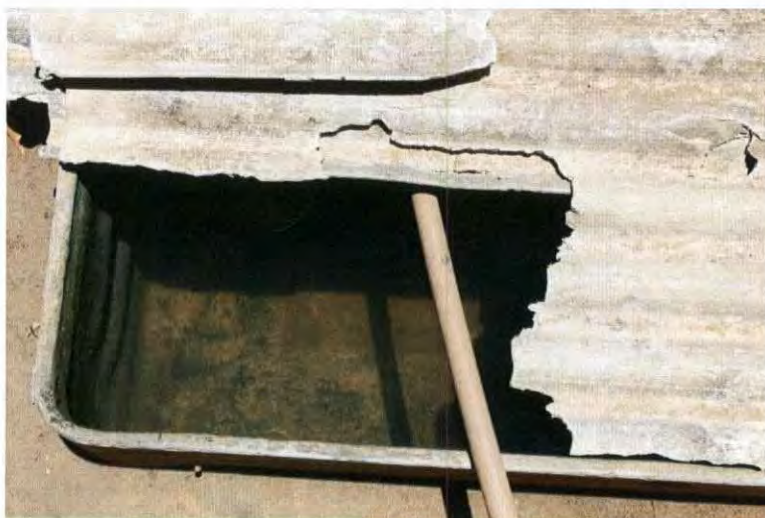
Fig. 2: Aloj. Estrada do Besouro – Água consumida pelos trabalhadores
