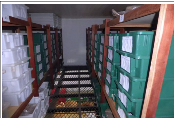
FIG. 15 - RT do NuPArq. Piso Superior. Observa-se as estantes de madeira sobre o piso de tela metálica que auxilia na ventilação da área.
