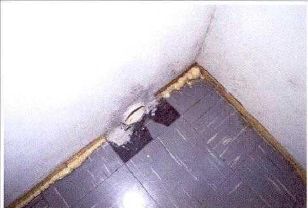
FIG. 11 - Reserva Técnica. Abertura para escoamento da água da enchente e vedações na parede.
