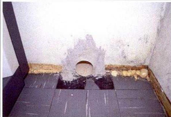
FIG. 10 – Reserva Técnica. Abertura para escoamento da água da enchente e vedações na parede.
