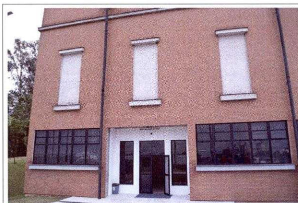
FIG. 1 – Prédio onde se localiza o CEPA.
