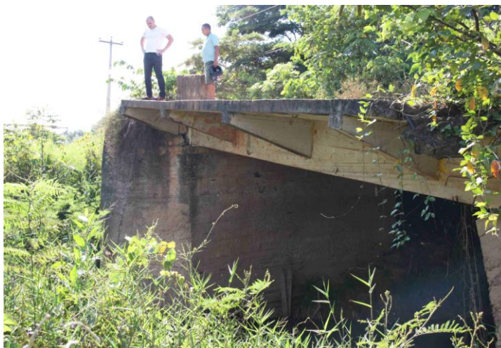
Ilustração 9: Inspeção na ponte da Estrada de Barcelos-Caurés
