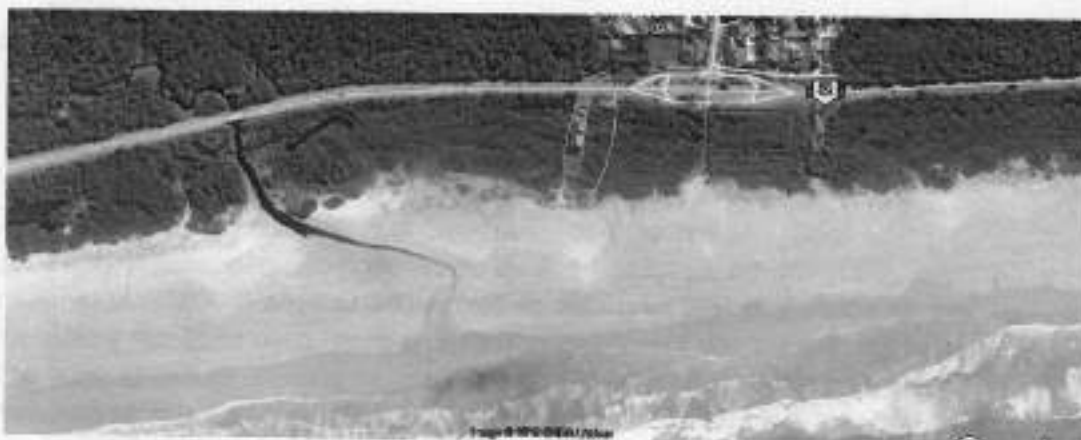
Situação da área em 2014 (polígono vermelho), recoberta por vegetação de restinga no interior da faixa de 300 metros a partir da linha preamar máxima, tidos como APP, conforme a Resolução CONAMA 303/2002, localizada na praia de Boraceia, São Sebastião.
